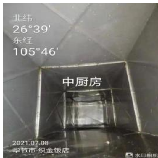
中厨房管道清洗后
