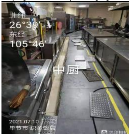
厨房地沟盖板清洗
