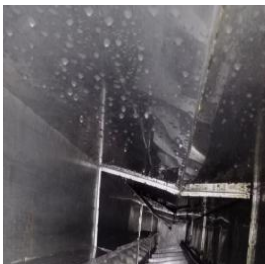
西厨房烟罩清洗后
