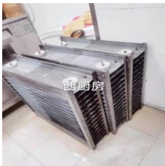
西厨房净化器清洗后
