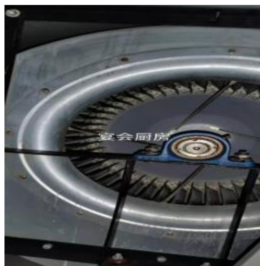
宴会厨房风机清洗后
