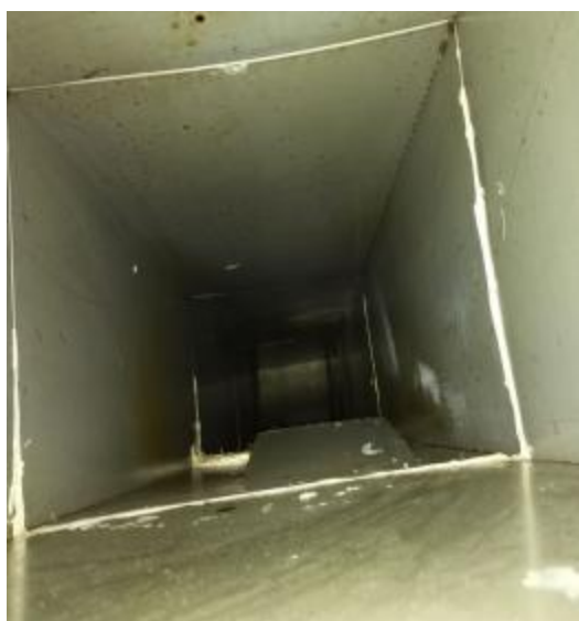
员工厨房管道清洗前
