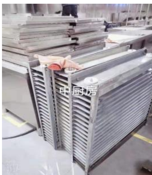
中厨房净化器清洗后
