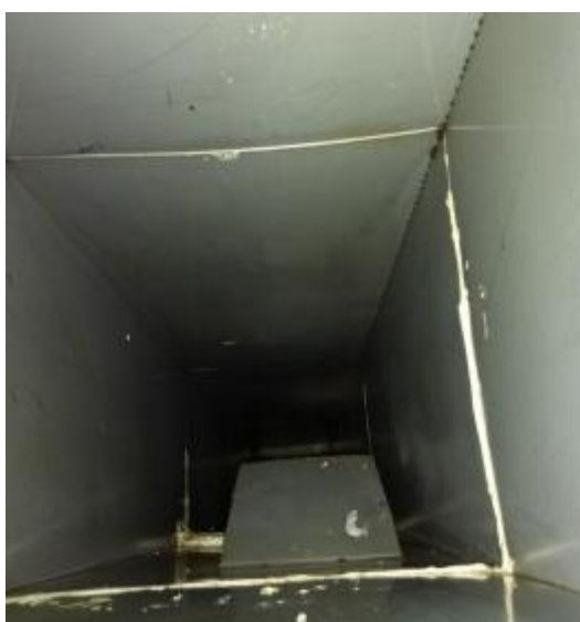
员工厨房管道清洗后
