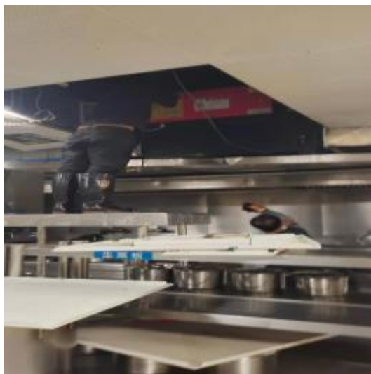
员工厨房净化器施工中
