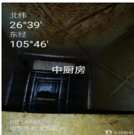
中厨房管道清洗前
