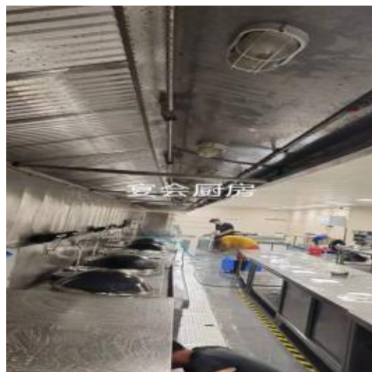
宴会厨房烟罩清洗后
