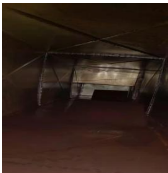
西厨房管道清洗前
