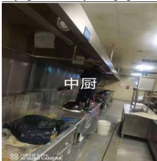
中厨房烟罩施工中
