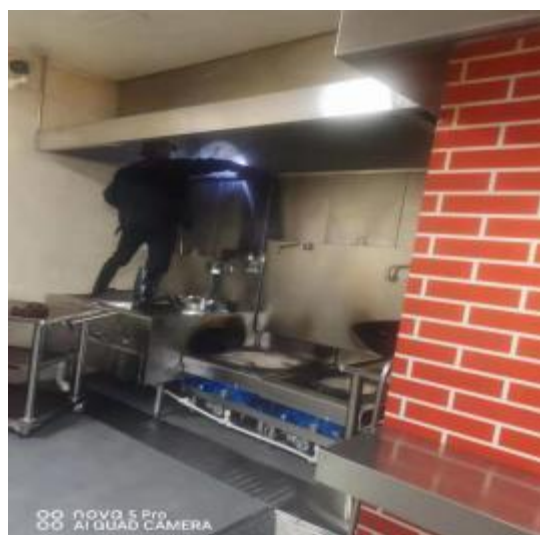
烤房烟罩施工中
