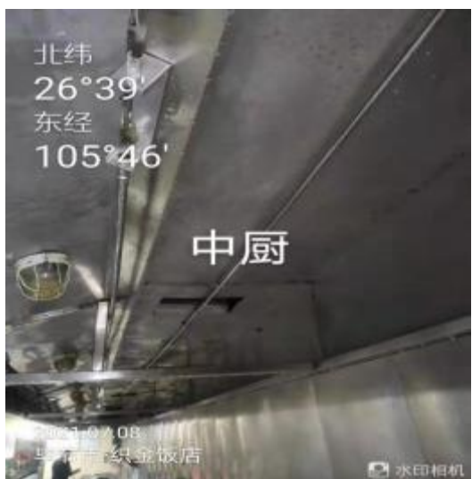
中厨房烟罩清洗后
