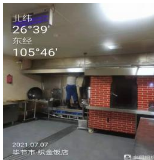
烤房烟罩施工中
