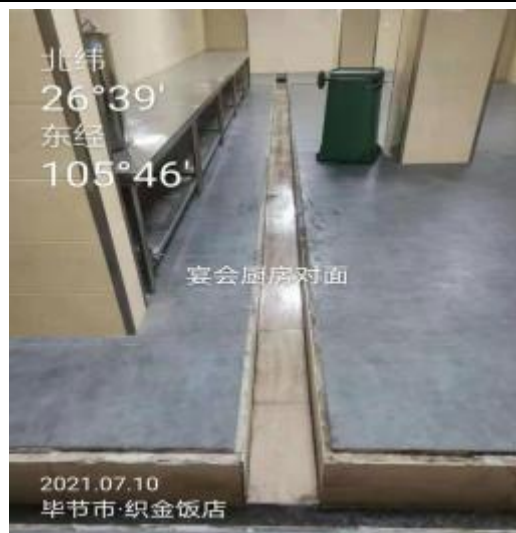
宴会厨房地沟清洗后
