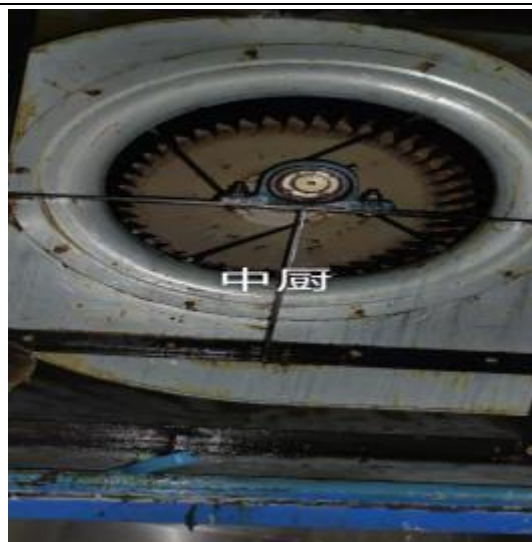
中厨房风机清洗后
