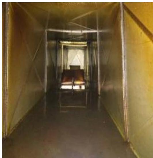
宴会厨房管道清洗前
