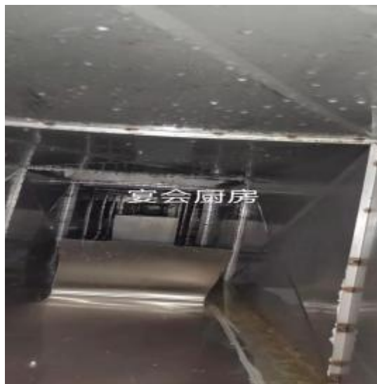
宴会厨房管道清洗后
