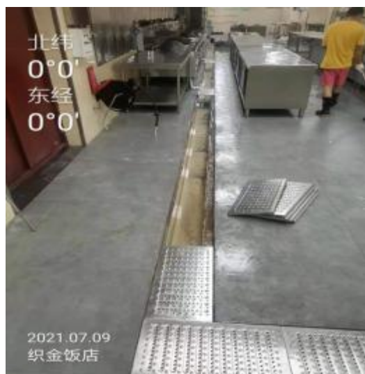
厨房地沟盖板清洗中
