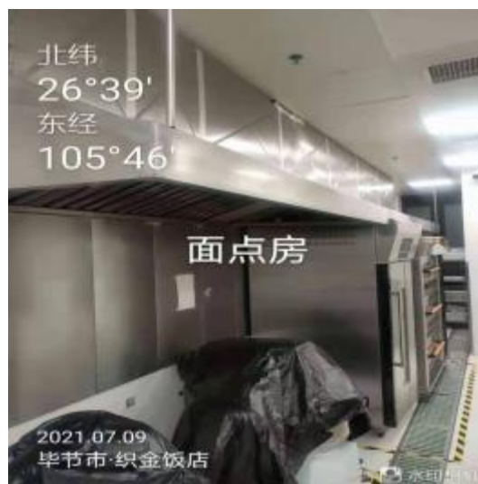
面点房烟罩施工中
