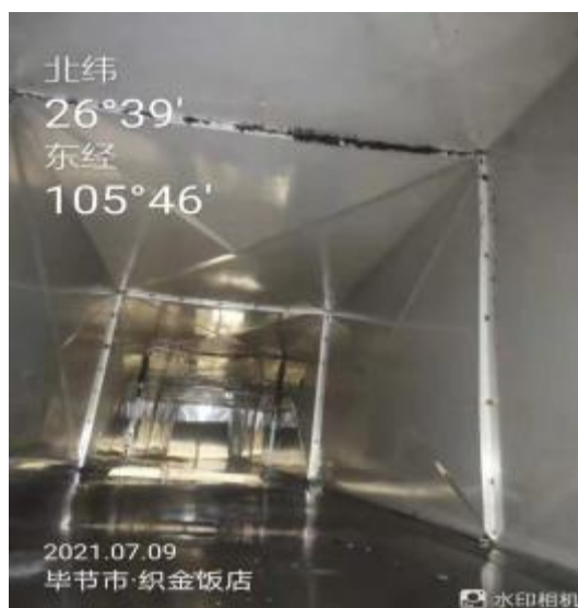
西厨房管道清洗后
