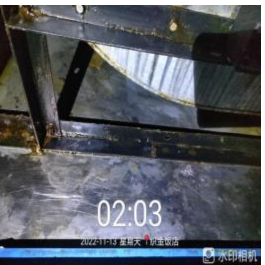
中厨房风机清洗后
