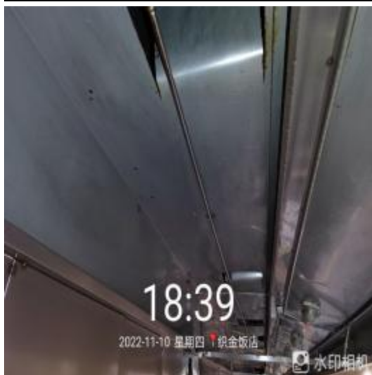
宴会厨房烟罩清洗前
