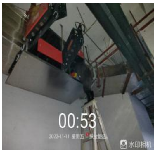
净化器机箱施工中
