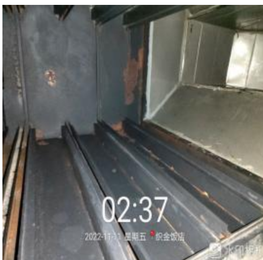
宴会厨房净化器机箱清洗后
