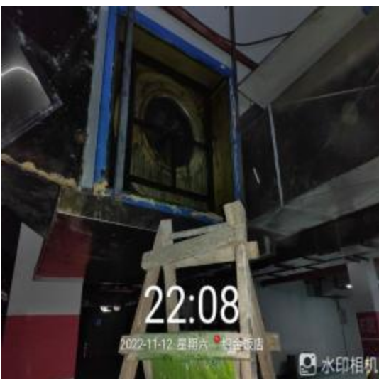
中厨房风机施工中
