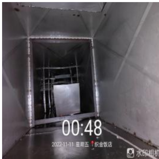
宴会厨房管道清洗后
