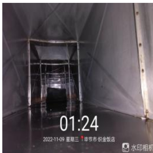
西厨房管道清洗后
