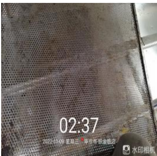
过滤网清洗后
