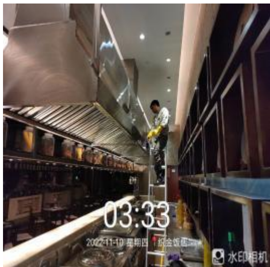
西厨房烟罩外表施工中
