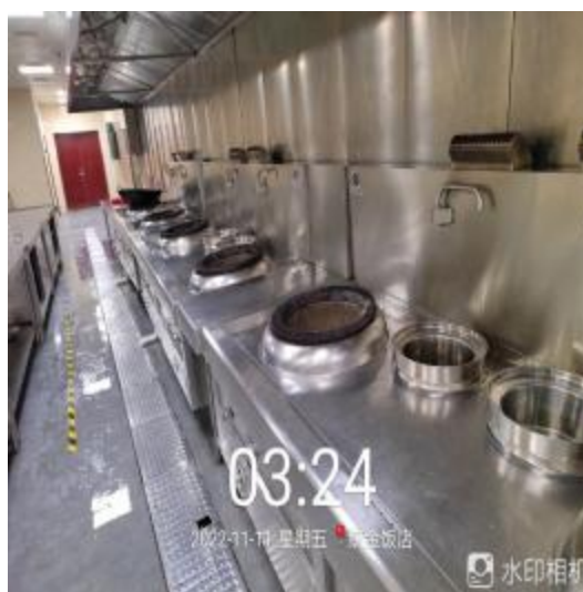
宴会厨房灶台清洗后
