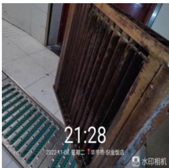
西厨房净化器清洗前
