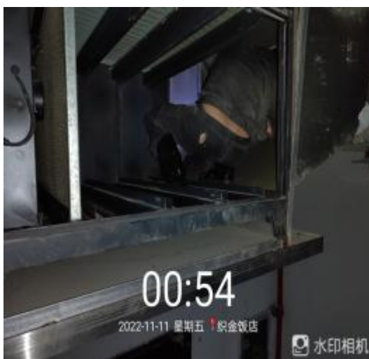
净化器机施工中
