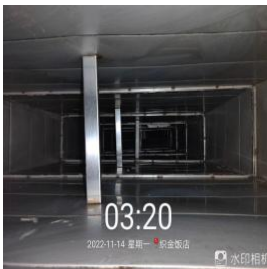
员工厨房管道清洗后
