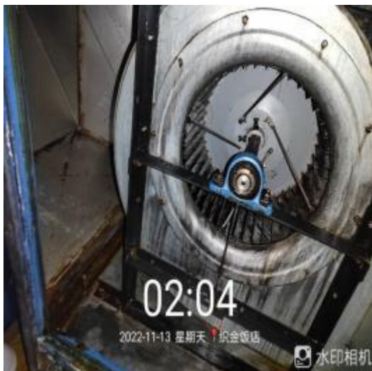
中厨房风机清洗后
