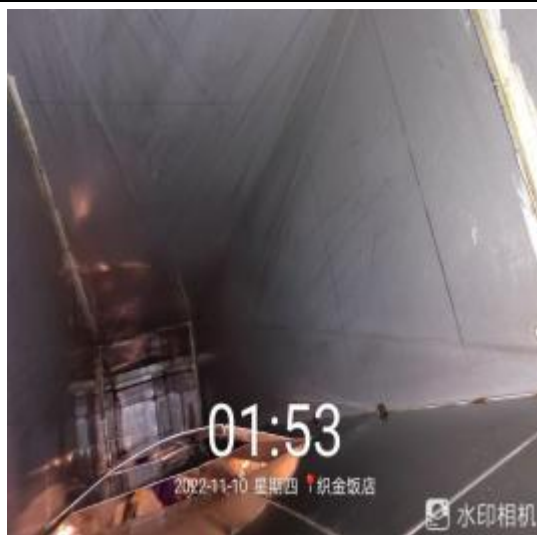
西厨房管道清洗后
