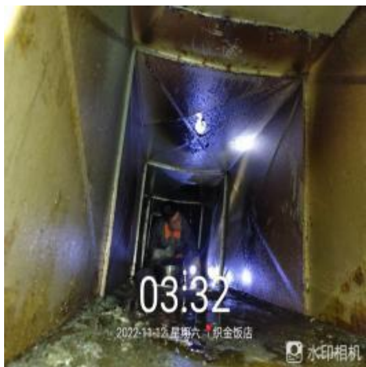
中厨房管道清洗中
