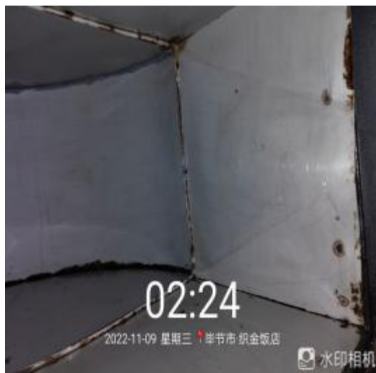
西厨房管道清洗后
