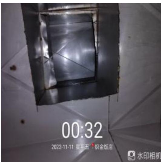
宴会厨房管道清洗后
