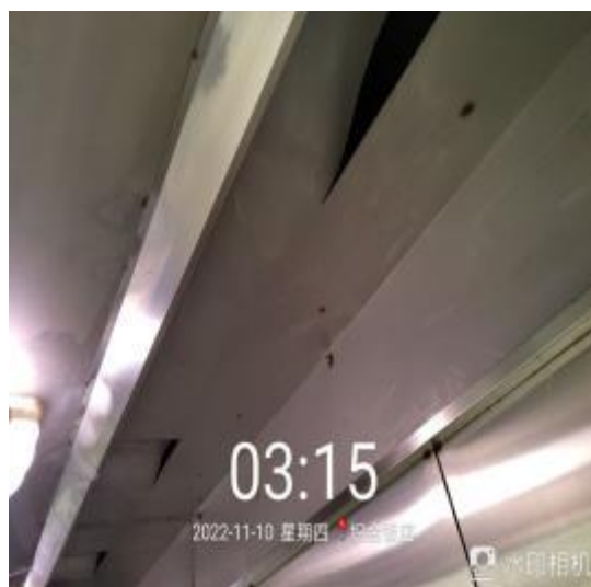
西厨房烟罩清洗后
