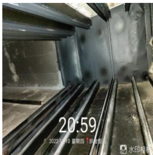
宴会厨房净化器机箱清洗前
