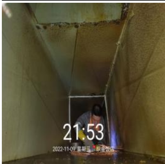
西厨房管道清洗中
