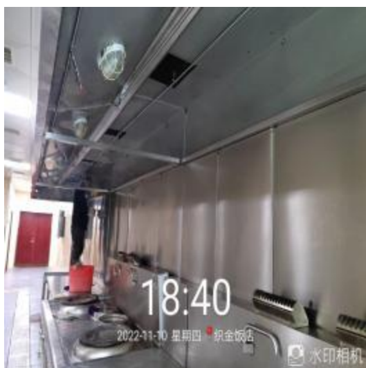
宴会厨房烟罩清洗前
