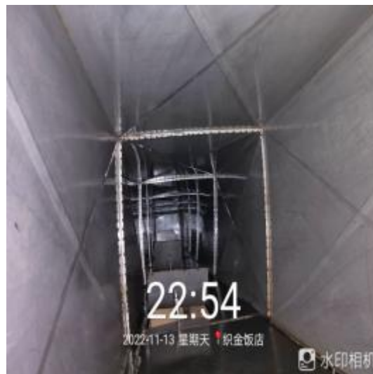
员工厨房管道清洗后
