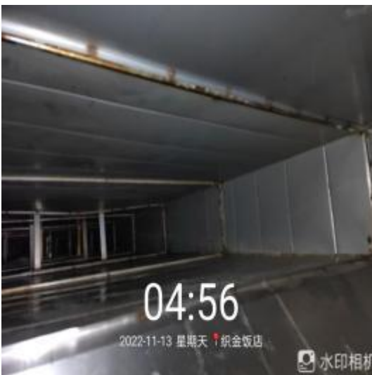
中厨房管道清洗后
