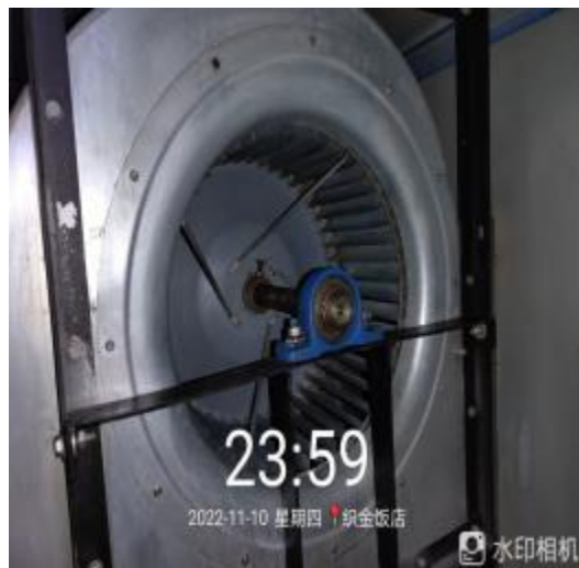
宴会厨房风机清洗后
