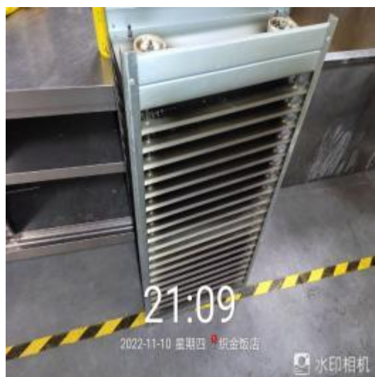
宴会厨房净化器清洗前
