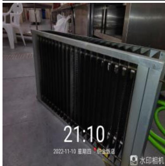
宴会厨房净化器清洗前
