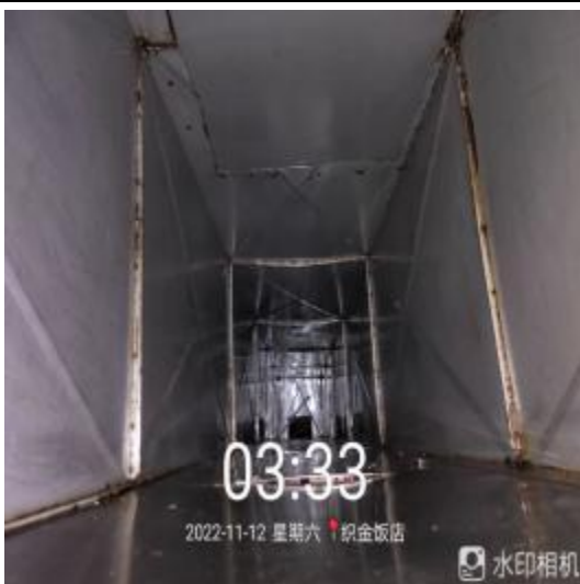
中厨房管道清洗后
