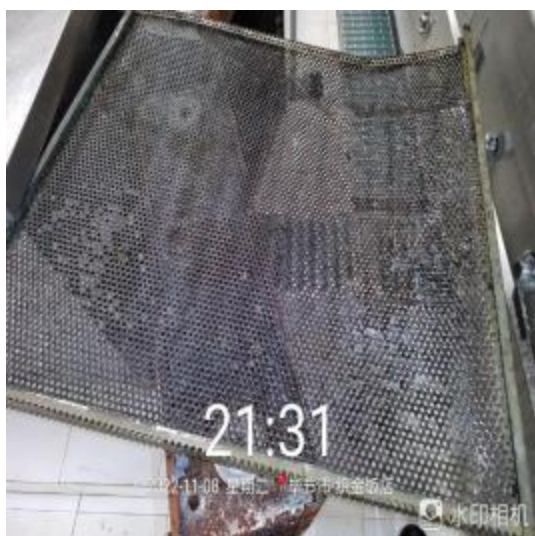
过滤网清洗前
