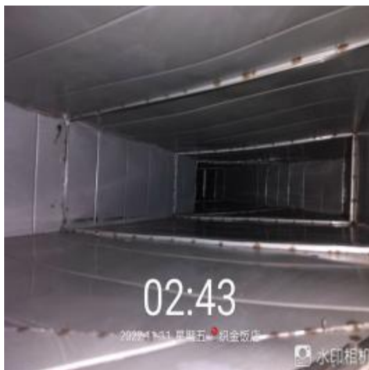
宴会厨房管道清洗后
