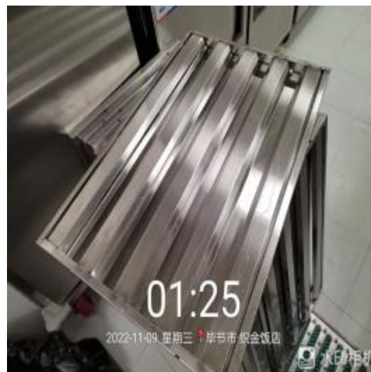
西厨防火板清洗后
