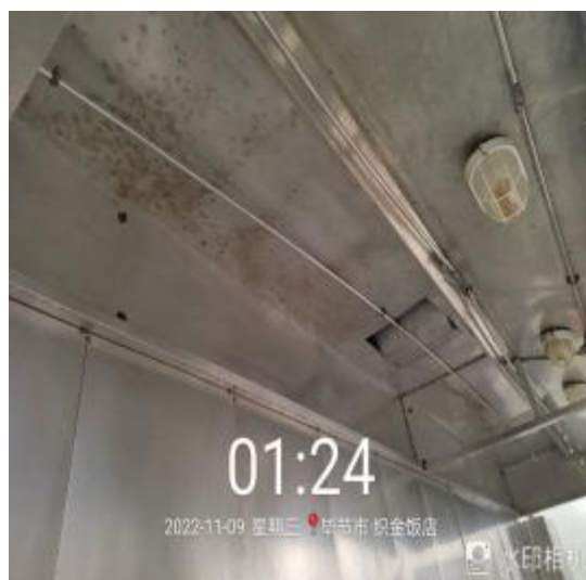
西厨房烟罩清洗后 2
