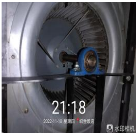
宴会厨房风机清洗前
