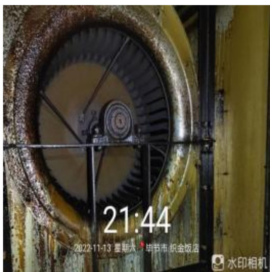
员工厨房风机清后
