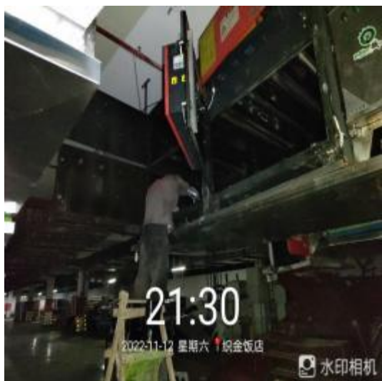
中厨房净化器施工中
