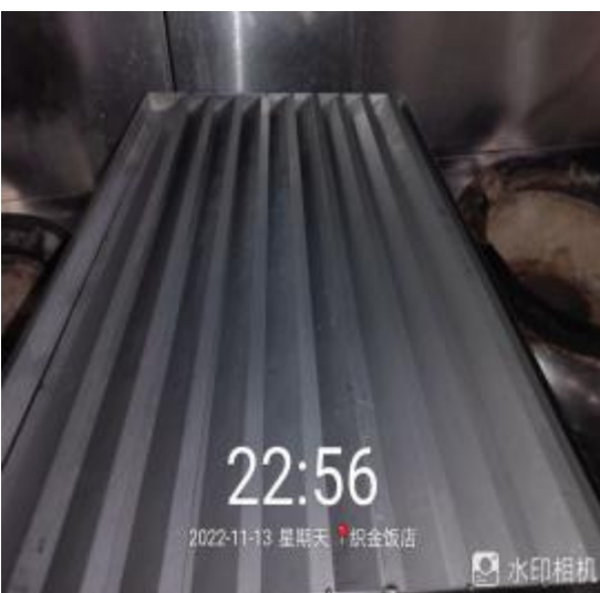
员工厨房防火板清洗后
