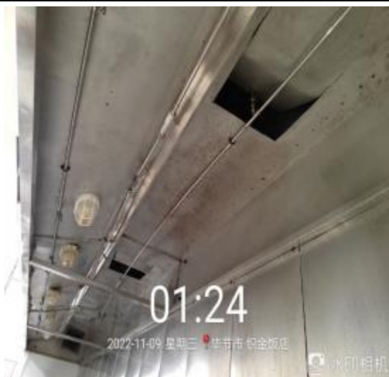
西厨房烟罩清洗后 1
