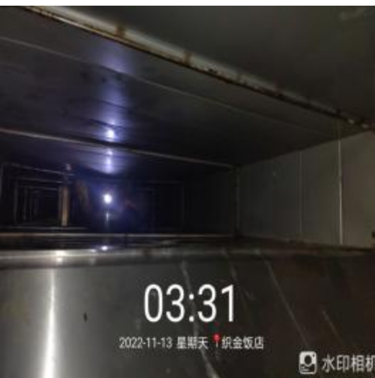
中厨房管道清洗中
