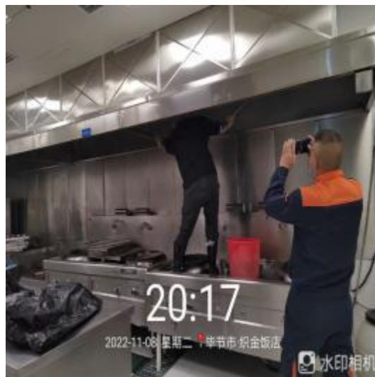
西厨房烟罩施工中
