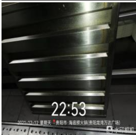
防火板清洗前
