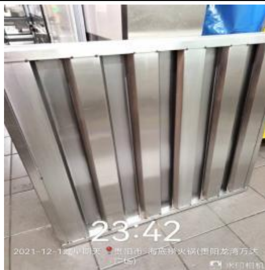
防火板清洗后
