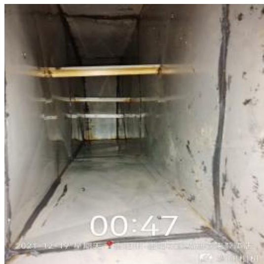
四楼管道清洗后 1
