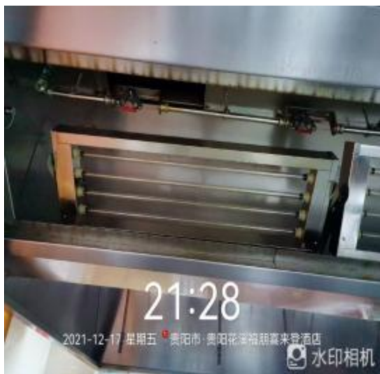
四楼烟罩施工前
