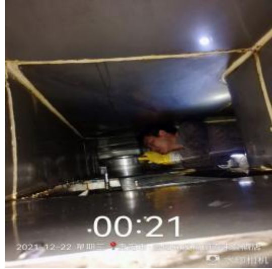
员工厨房管道清洗后 1
