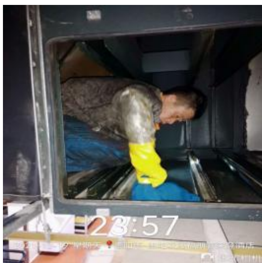
二楼净化器机箱清洗中
