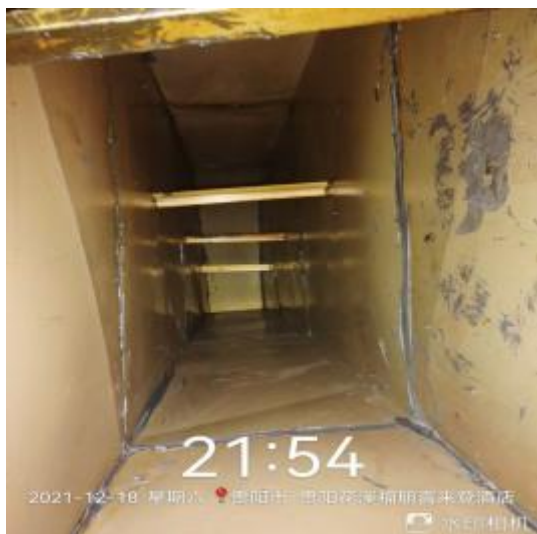
四楼管道清洗前 1
