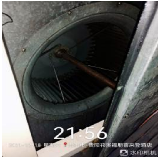
四楼风机清洗前 1
