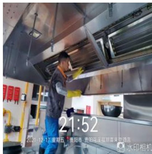
四楼烟罩施工中
