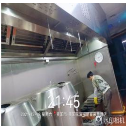
四楼烧腊房烟罩清洗中
