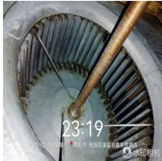
四楼风机清洗后 1
