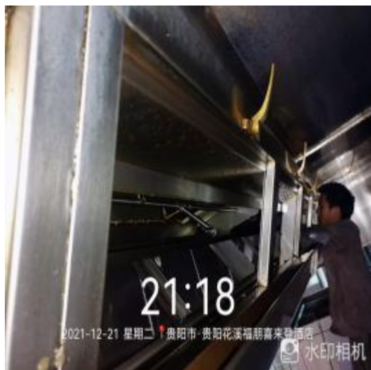
员工厨房烟罩施工中
