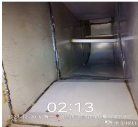
二楼管道清洗后
