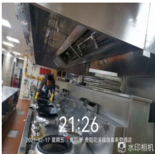
四楼烟罩施工中
