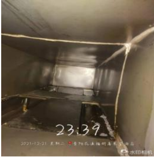
员工厨房管道清洗中 1
