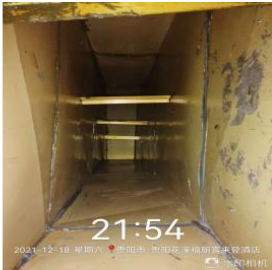
顶楼管道清洗前 1
