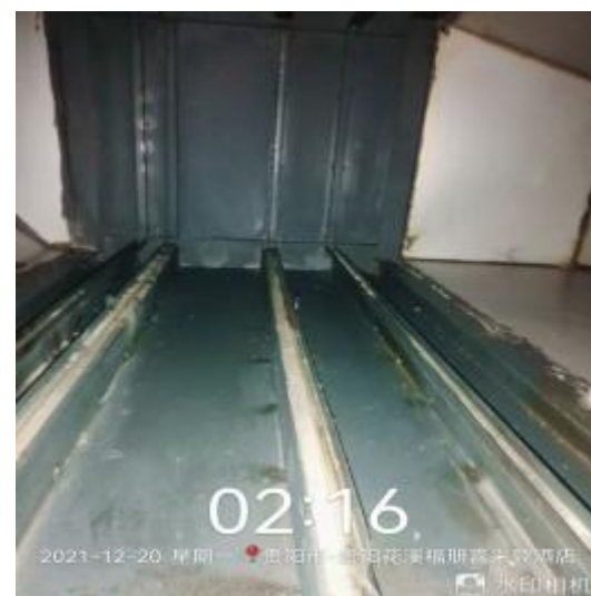
二楼净化器机箱清洗后
