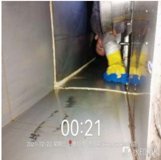
员工厨房管道清洗中 2
