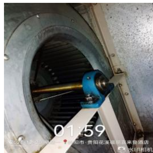
二楼风机清洗后
