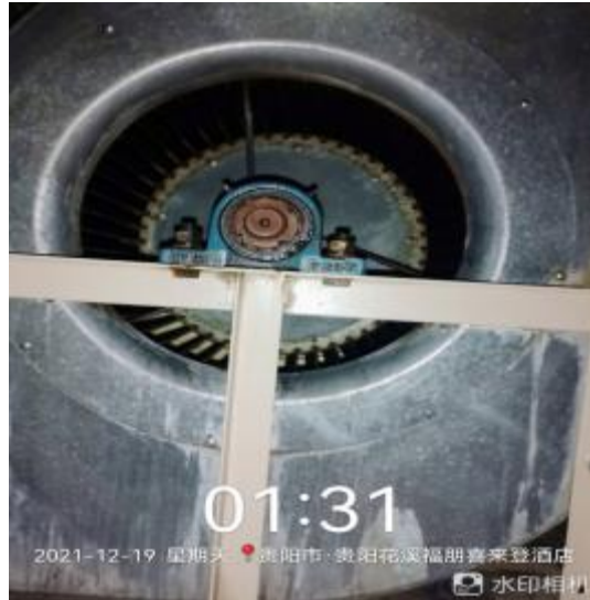
四楼风机清洗后 2
