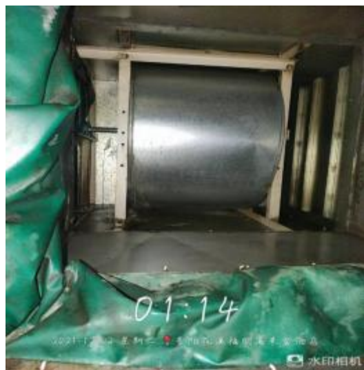
员工厨房风机清洗后
