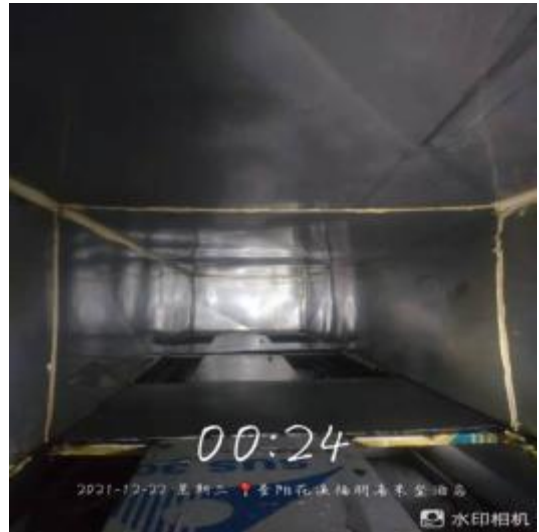
员工厨房管道清洗后 2
