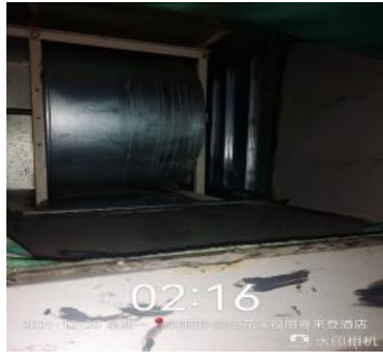
二楼风机清洗后
