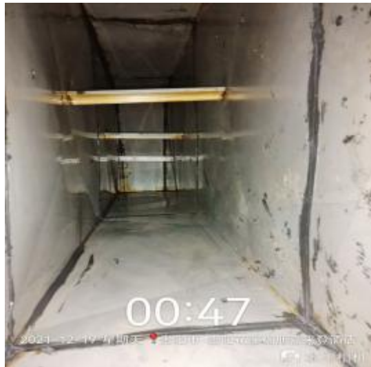
顶楼管道清洗后 1
