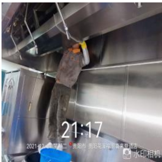
员工厨房烟罩施工中
