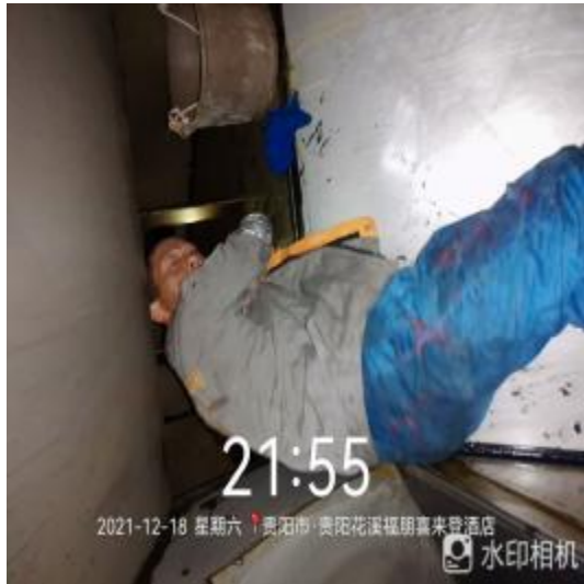
四楼管道清洗前 2
