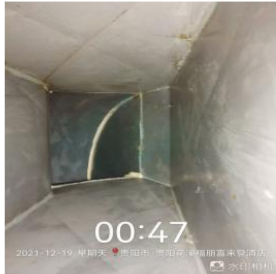
四楼管道清洗后 2
