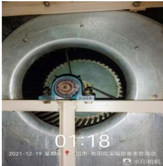
四楼风机清洗前 2
