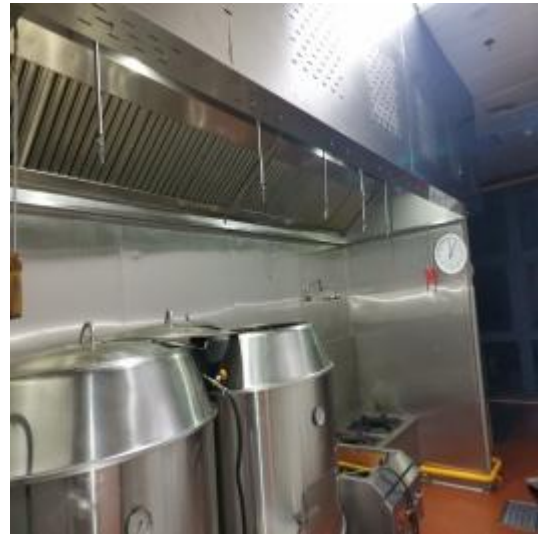
四楼烧腊房烟罩清洗后
