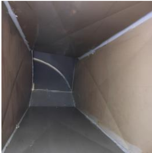
四楼管道清洗前 1
