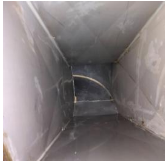
四楼管道清洗后 1
