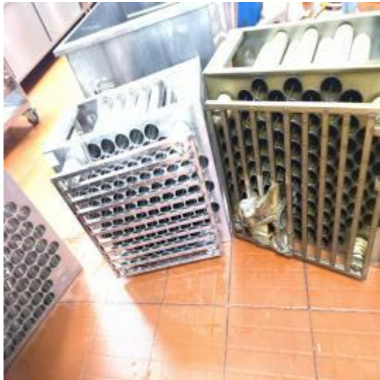
四楼净化器清洗中
