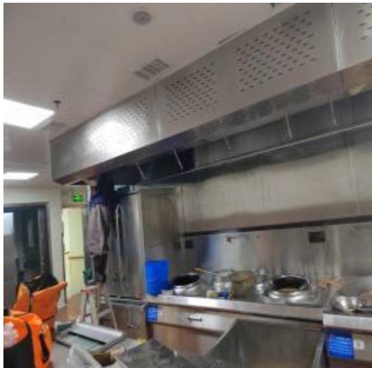
员工厨房烟罩施工中
