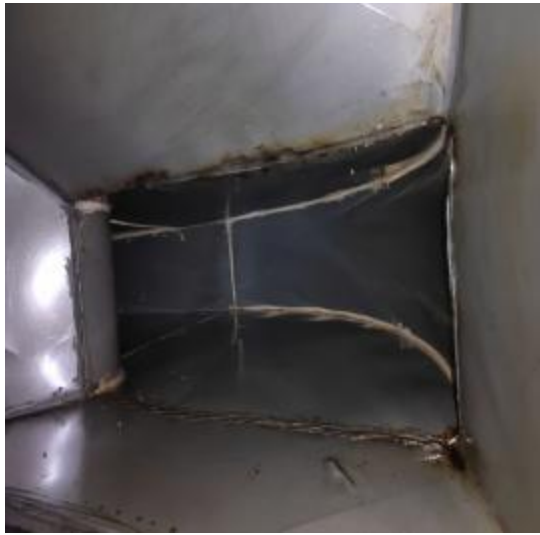
员工厨房管道清洗中 2
