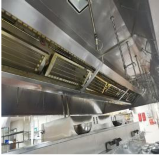
四楼烟罩施工前
