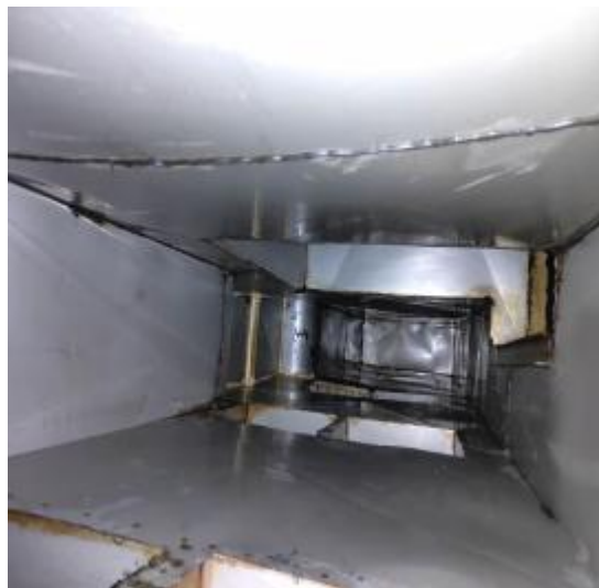
四楼管道清洗后 2
