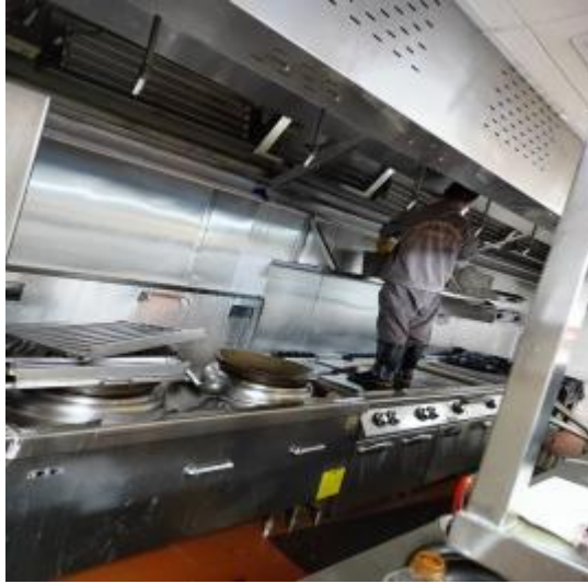
二楼厨房烟罩施工中
