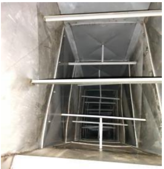
顶楼管道清洗后 1
