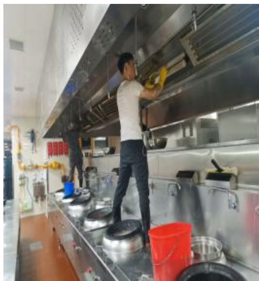
四楼烟罩施工中
