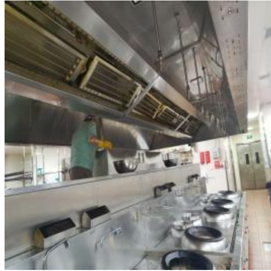
四楼烟罩施工中
