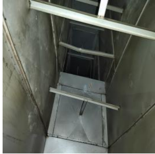
顶楼管道清洗后 2
