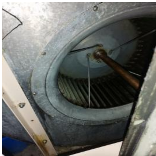
四楼风机清洗后 1
