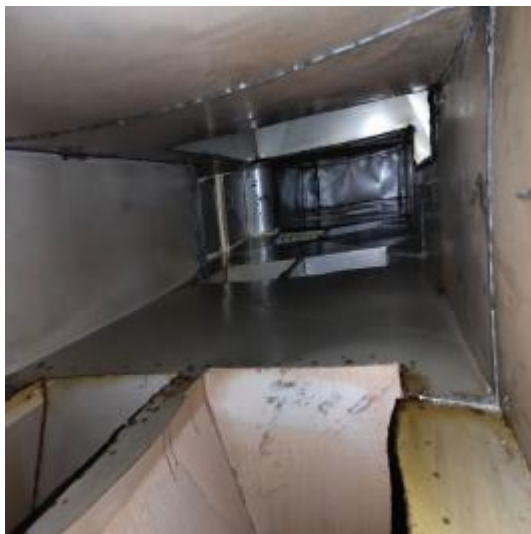
四楼管道清洗前 2
