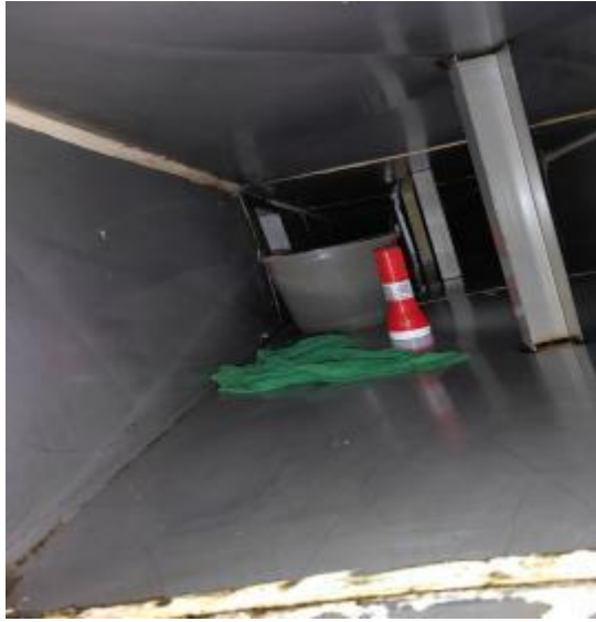
员工厨房管道清洗中 1
