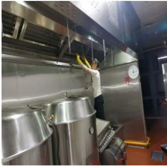
四楼烧腊房烟罩清洗中
