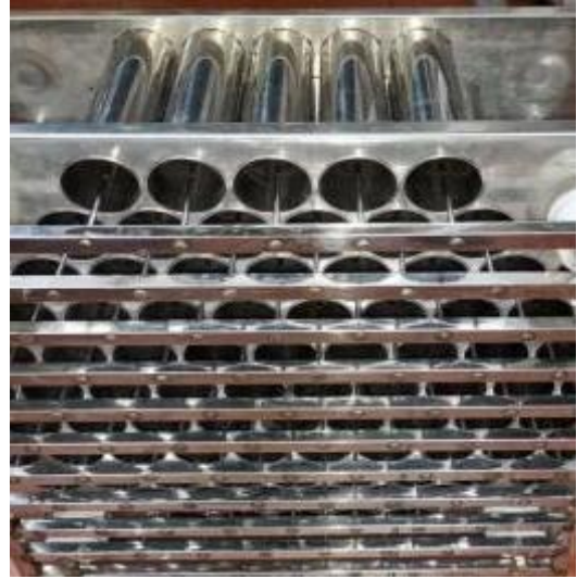
员工厨房净化器清洗后
