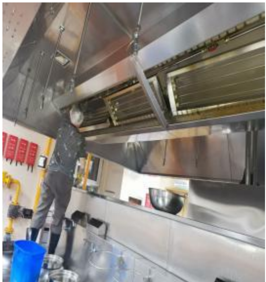
四楼烟罩施工中
