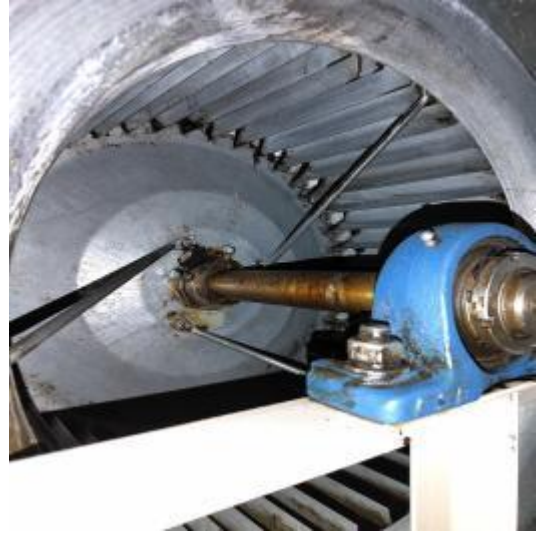
二楼风机清洗后
