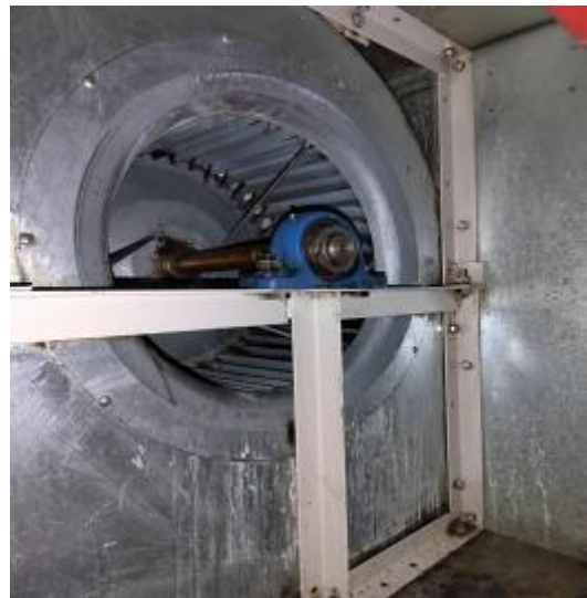
二楼风机清洗后
