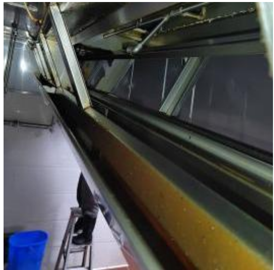
员工厨房烟罩施工中
