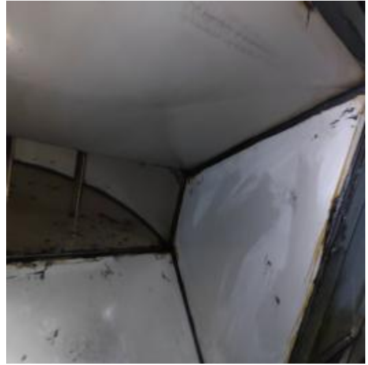
二楼管道清洗后
