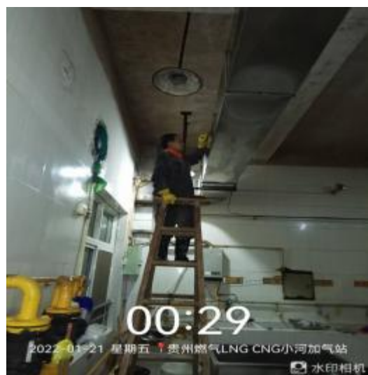
管道外观清洗中
