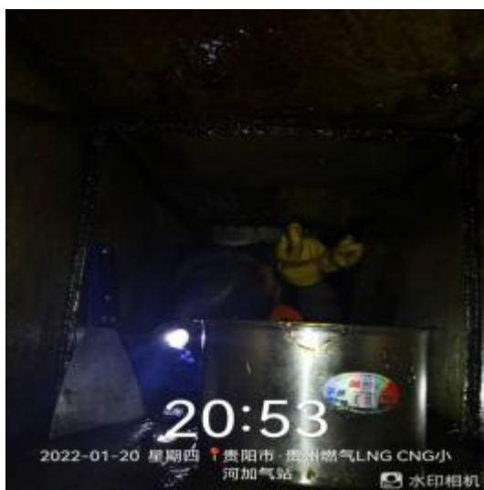
管道内部施工中
