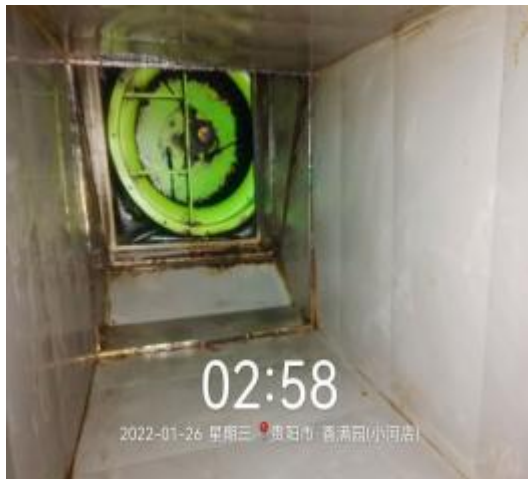
风机管道清洗后
