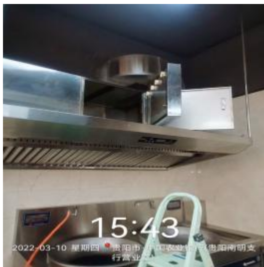
净化器机箱施工中
