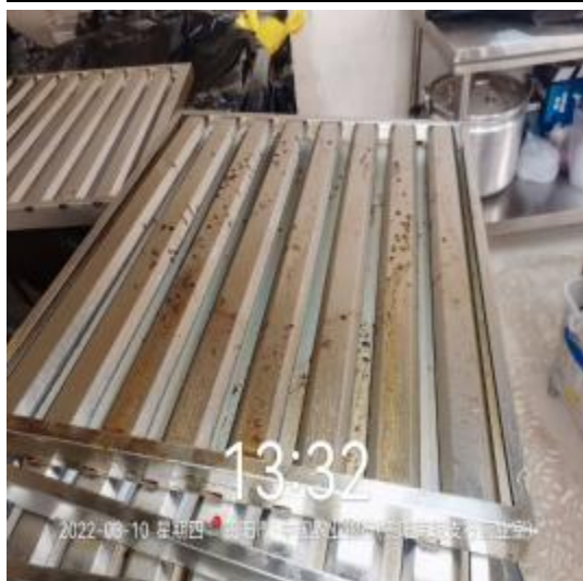
防火板清洗前
