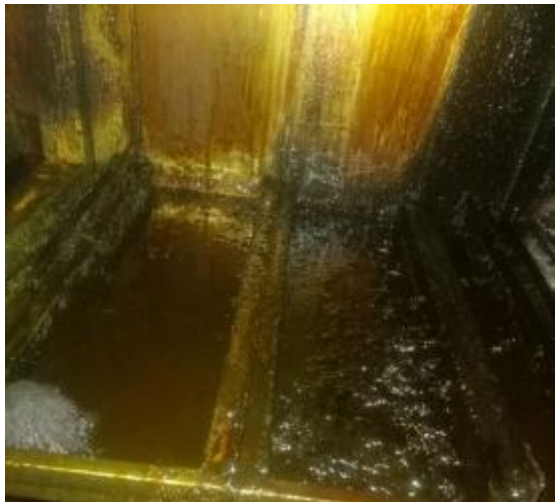
净化器机箱清洗前
