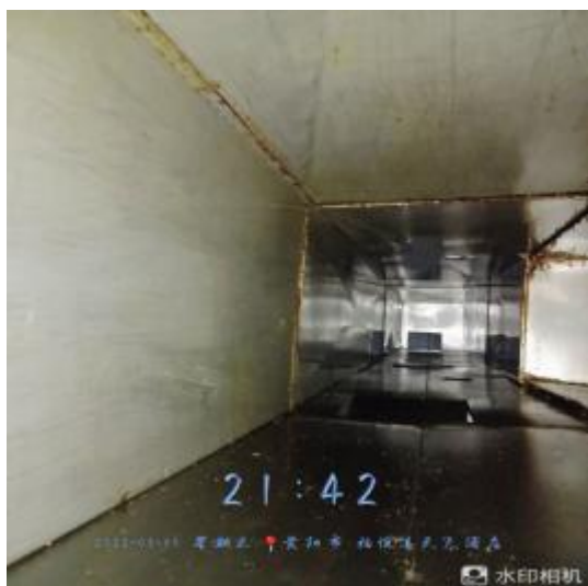
西厨房管道清洗中
