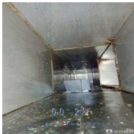
西厨房管道清洗后
