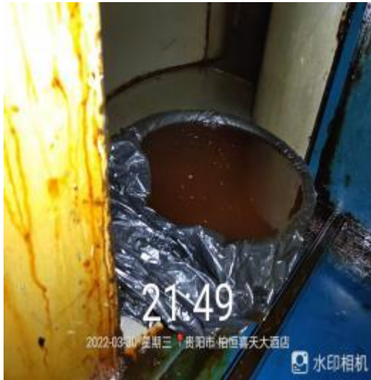
管道风机清洗中
