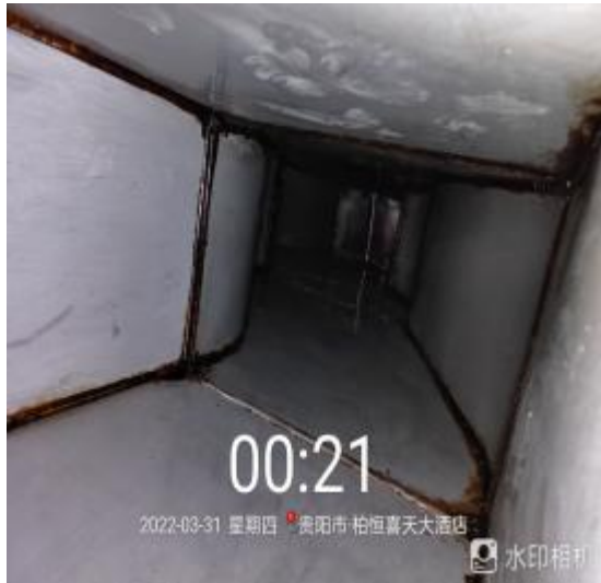
管道风机清洗后
