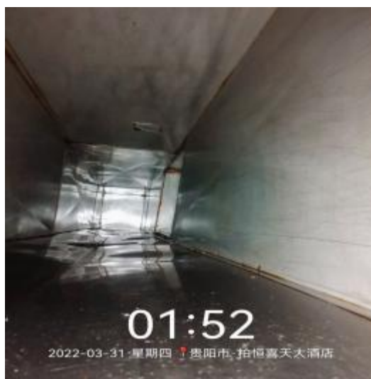
中厨房管道清洗后
