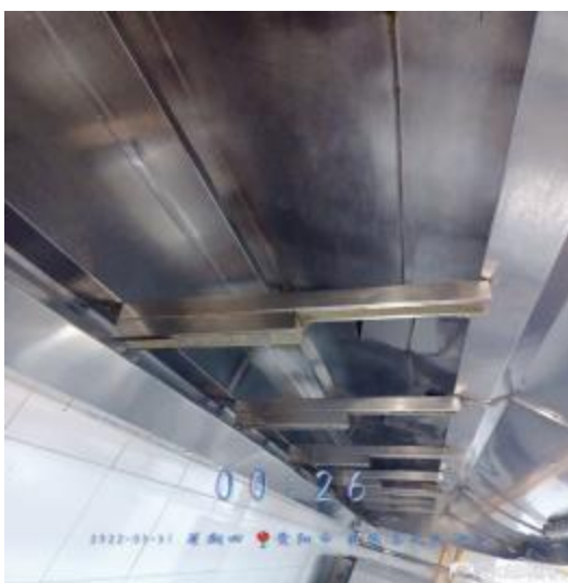
西厨房烟罩清洗后
