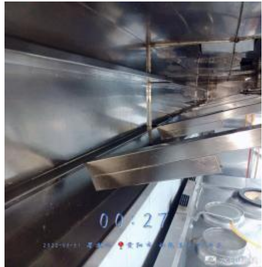
西厨房烟罩清洗后
