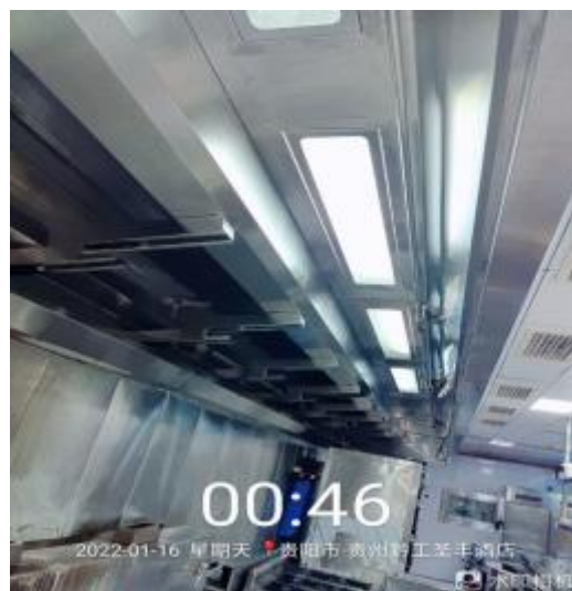
北楼厨房烟罩清洗后
