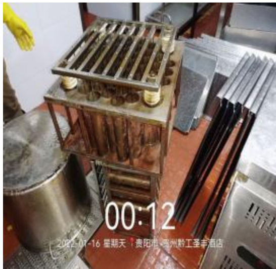
净化器施工中
