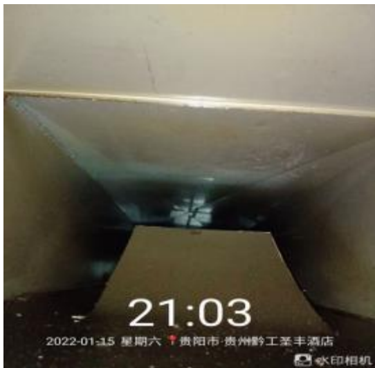
北楼管道清洗前
