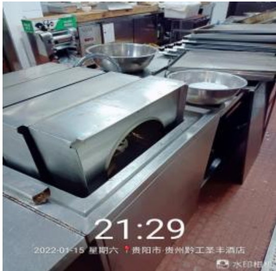
北楼风扇清洗中
