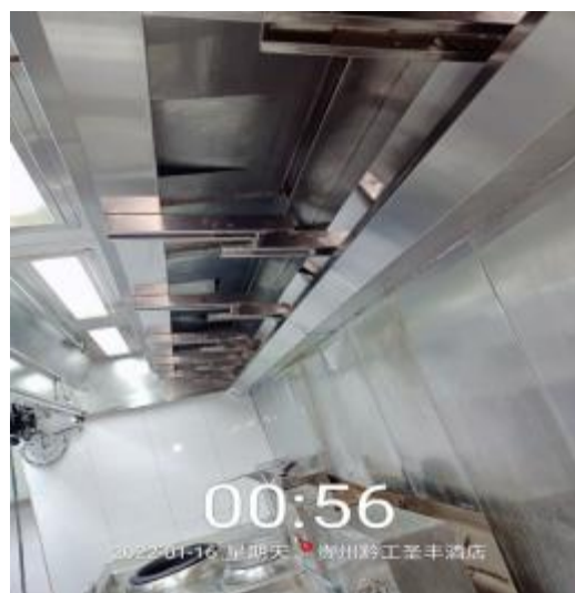
北楼厨房烟罩清洗后
