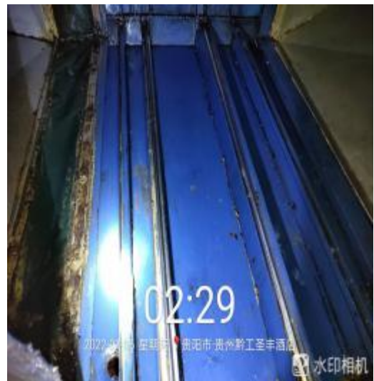
净化器机箱清洗后
