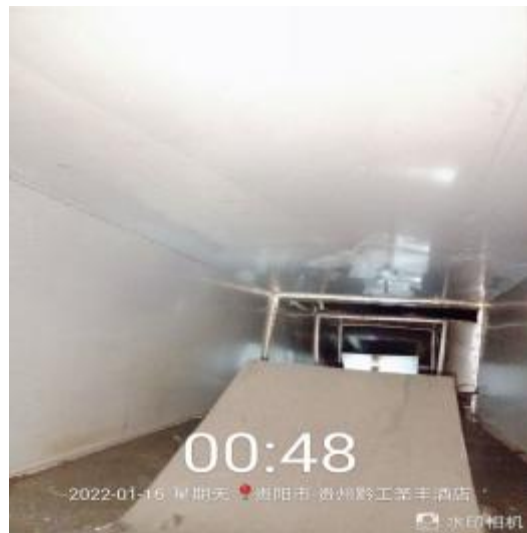
北楼管道清洗后
