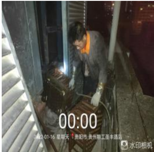
净化器施工中
