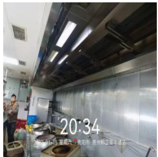
中厨房烟罩施工中
