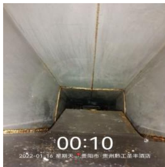
中厨房管道清洗后
