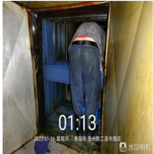
净化器机箱施工中
