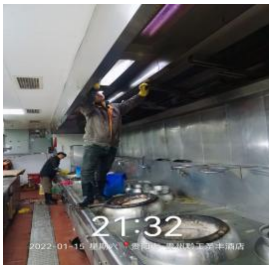
中厨房烟罩施工中
