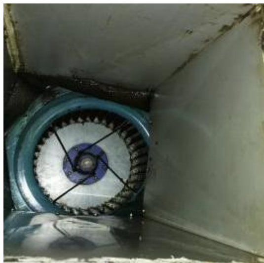
管道风机清洗后
