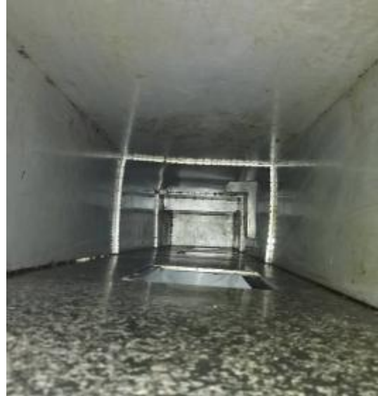
一食堂管道清洗后
