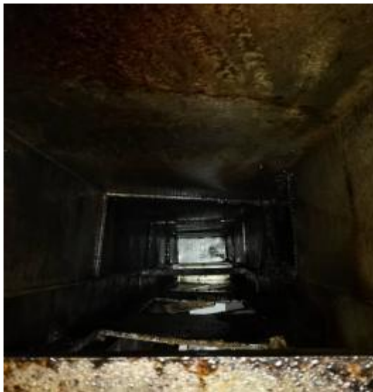
一食堂管道清洗前
