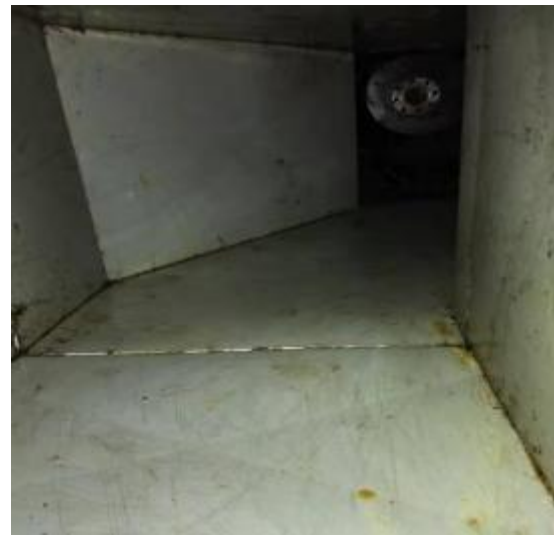
二食堂管道风机清洗后
