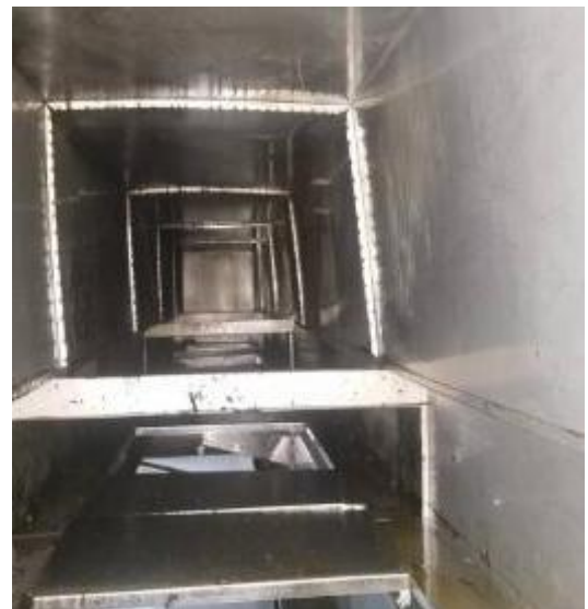
一食堂管道清洗后
