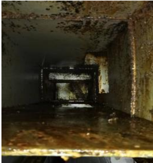
一食堂管道清洗前
