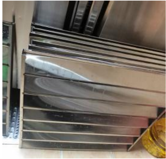
二食堂防火板清洗后
