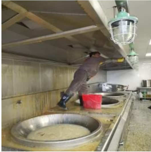
二食堂烟罩施工中
