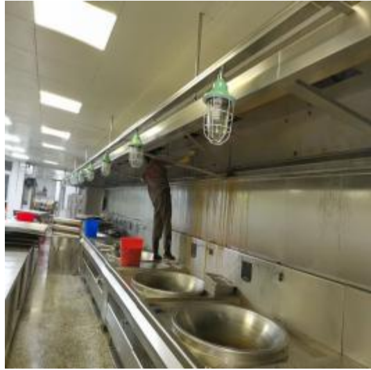
二食堂烟罩施工中
