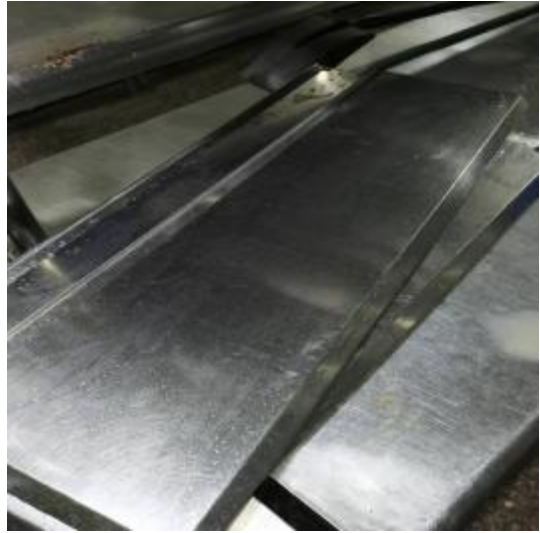
一食堂防火板清洗后
