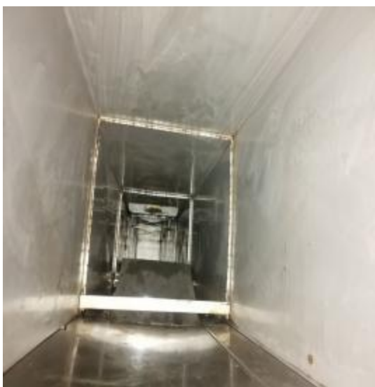
二食堂管道清洗后
