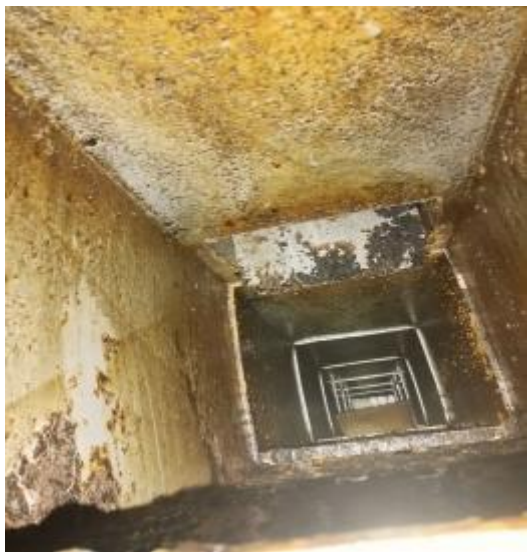
二食堂管道清洗前
