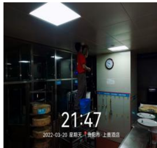
天花板施工中
