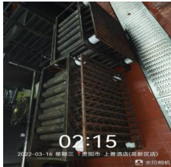
净化器施工做
