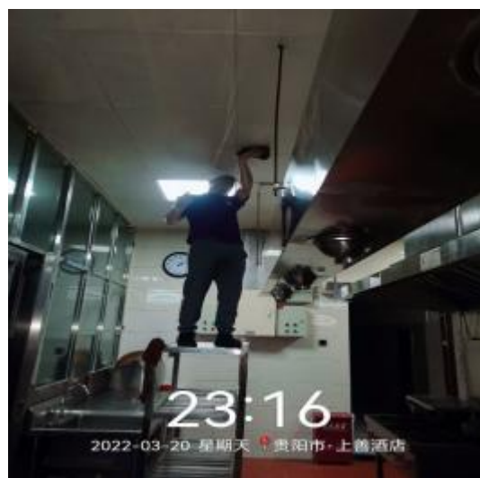
天花板施工中
