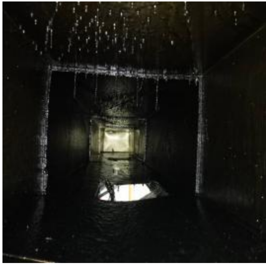
烟罩同步管道清洗前
