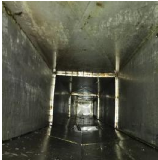
风机施工中后
