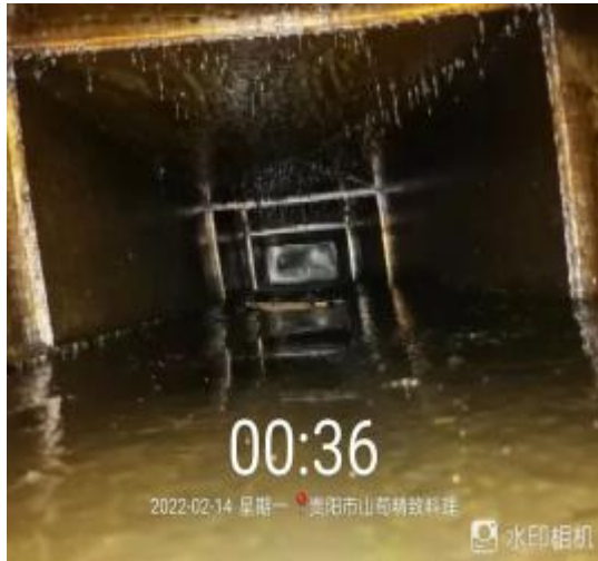
烟罩同步管道清洗前
