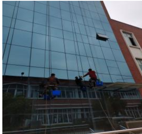
幕墙玻璃清洗施工中
