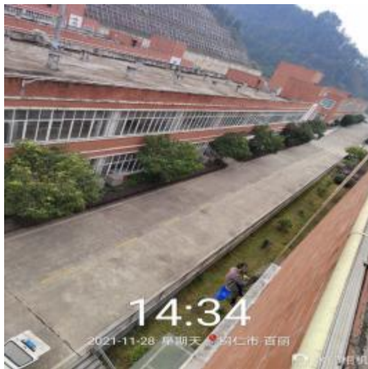
幕墙玻璃清洗中
