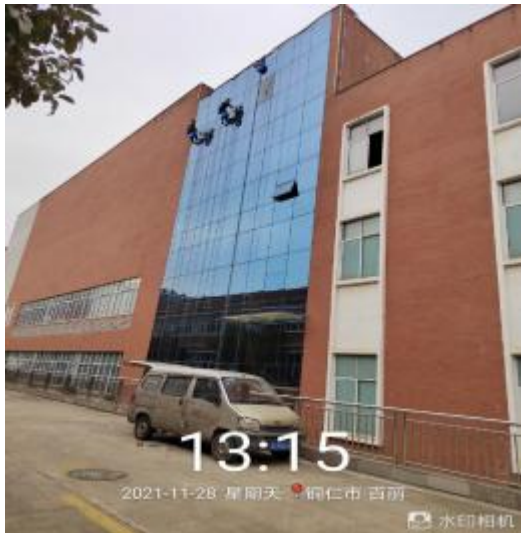
幕墙玻璃清洗施工中
