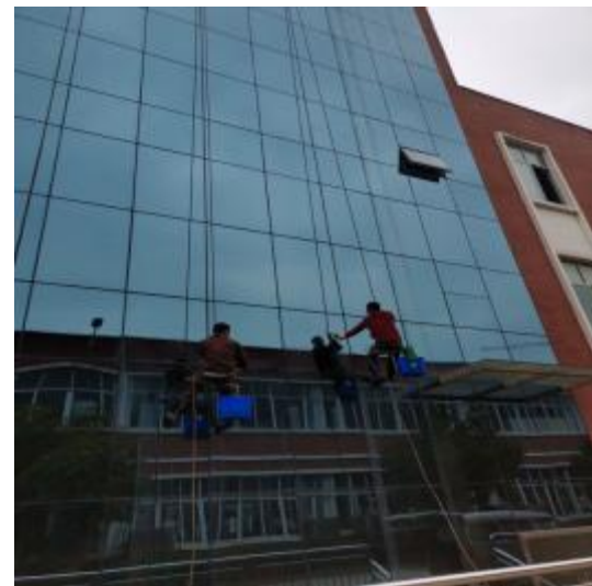
幕墙玻璃清洗中
