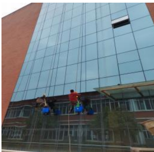
幕墙玻璃清洗施工中
