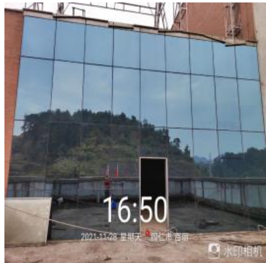
幕墙玻璃清洗后
