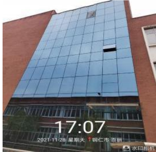
幕墙玻璃清洗后
