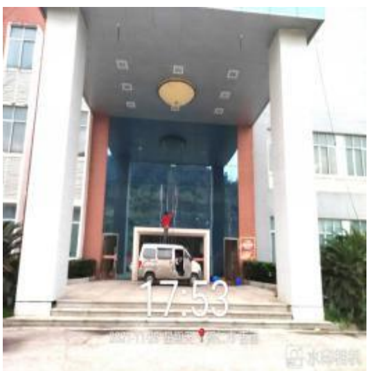
大门幕墙清洗中
