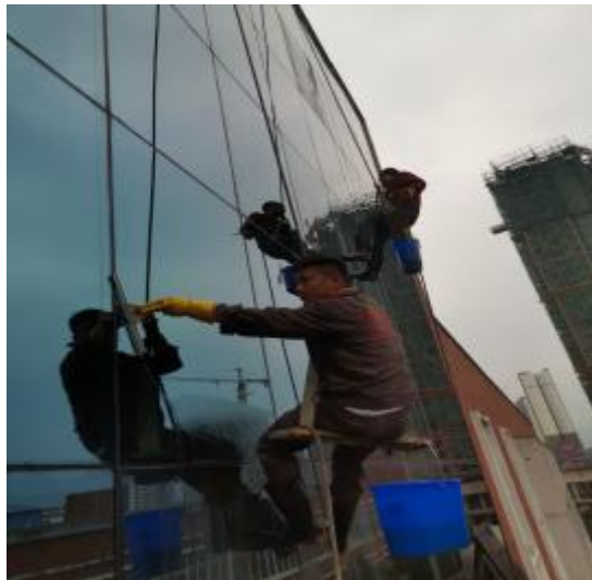
幕墙玻璃清洗施工中
