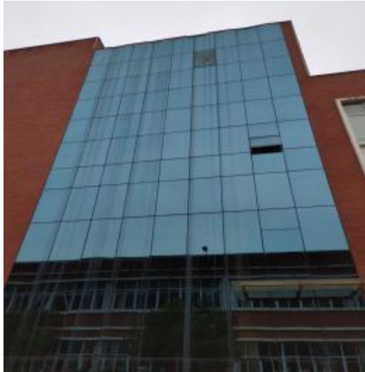
幕墙玻璃清洗前
