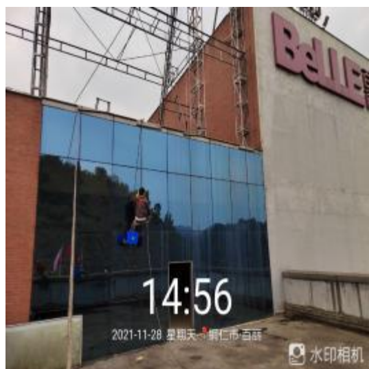
幕墙玻璃清洗中
