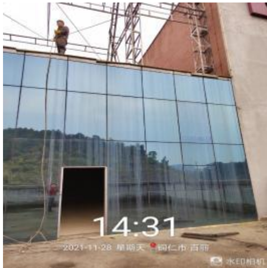
幕墙玻璃清洗中
