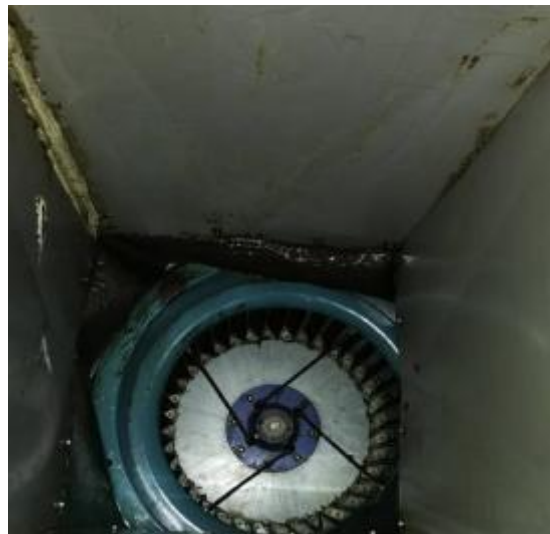
风机管道清洗后
