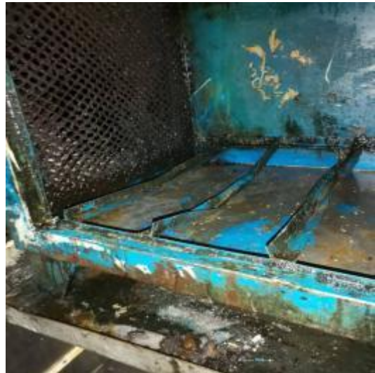
净化器内部清洗后
