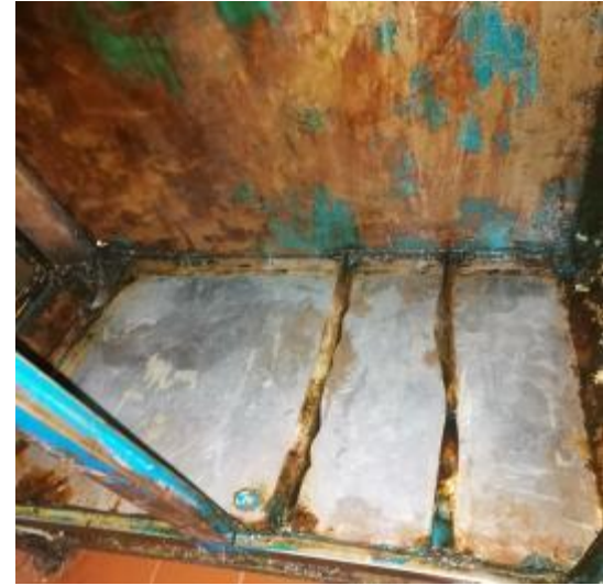
净化器机箱清洗后
