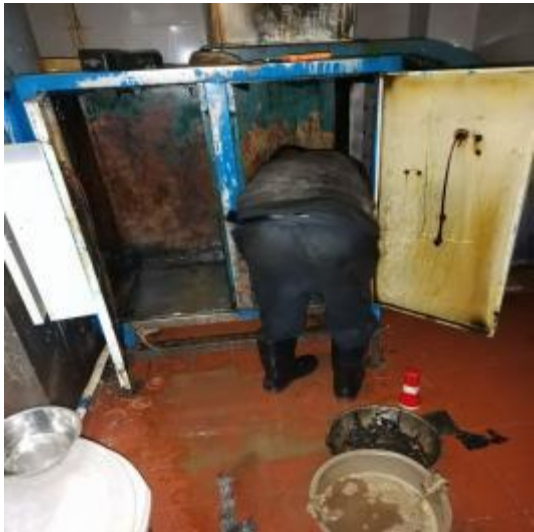
净化器施工中
