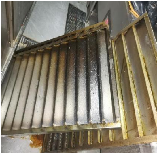
防火板清洗前
