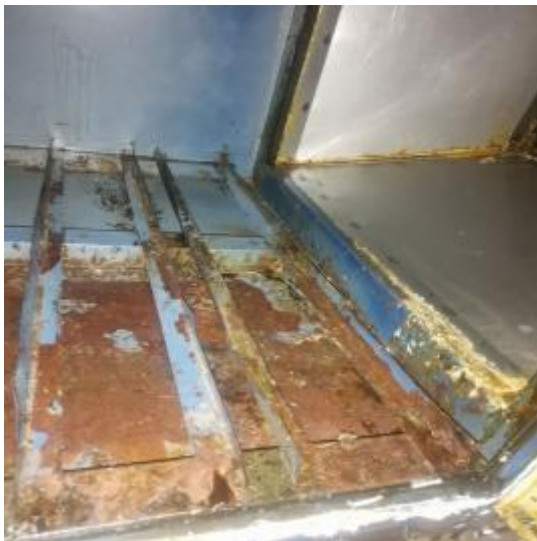
净化器机箱清洗后
