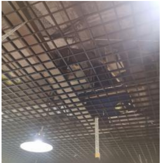
净化器施工中
