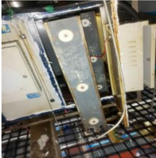
净化器施工中
