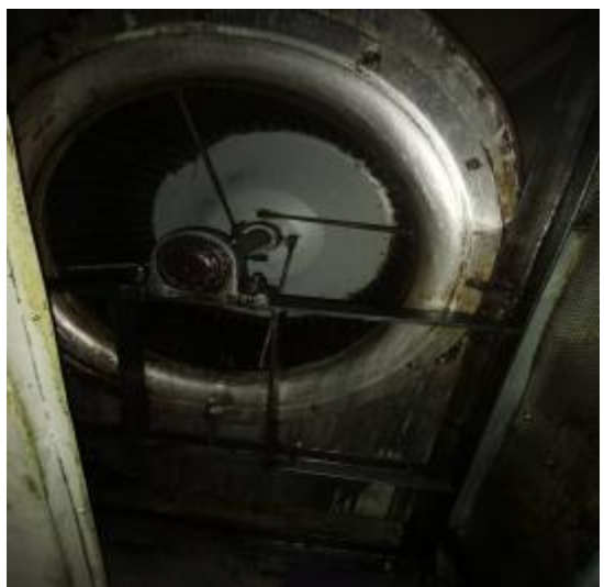
中厨房风机清洗后
