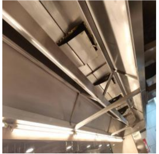
西厨房烟罩清洗后
