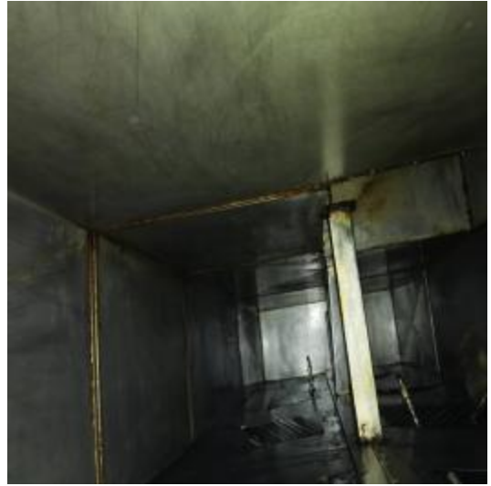
西厨房管道清洗后 1
