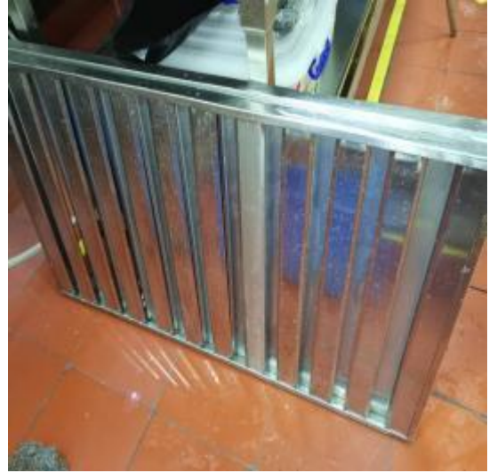
员工厨房防火板清后
