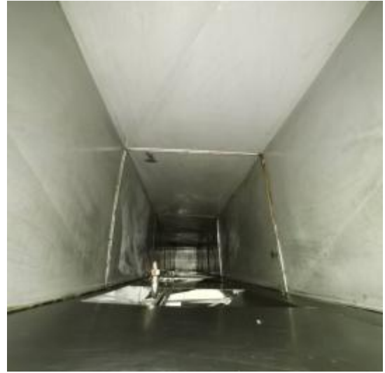
员工厨房管道清洗后 1
