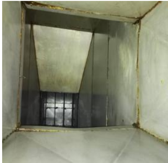
中厨房管道清洗后 3
