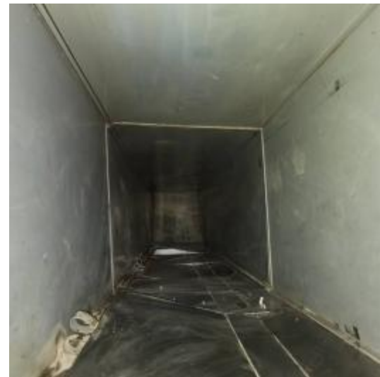
西厨房管道清洗后 2
