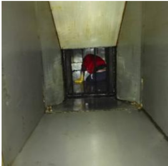
中厨房管道清洗中 3
