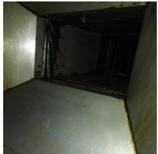
员工厨房管道清洗后 2
