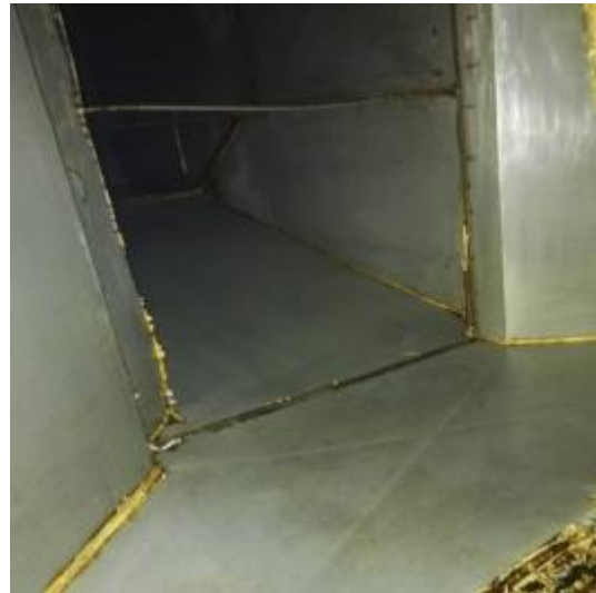
中厨房管道清洗后 2
