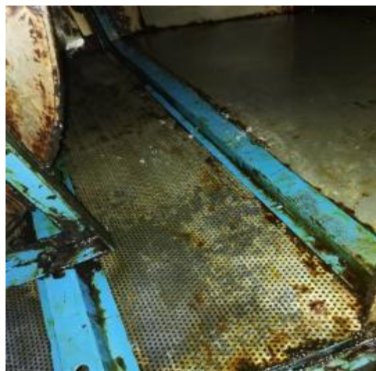
西厨房风机清洗后
