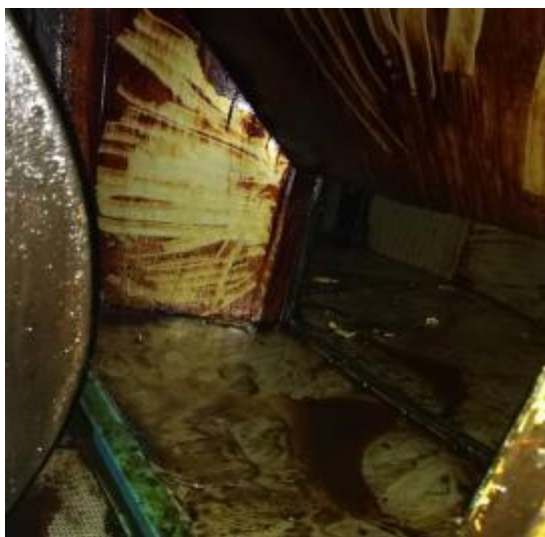
西厨房风机清洗前
