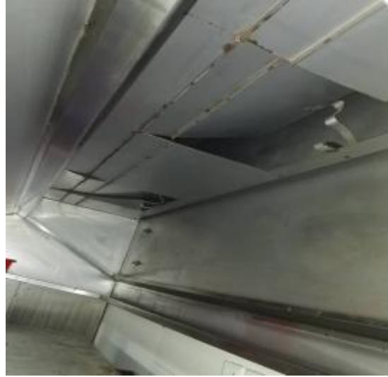
西厨房烟罩清洗后
