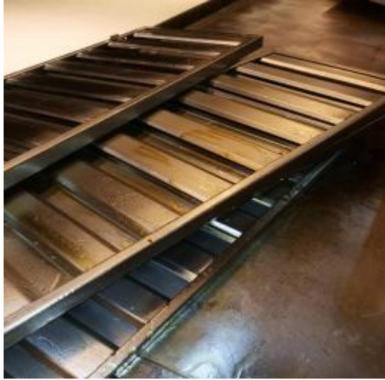
西厨房防火板清洗前
