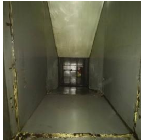
中厨房管道清洗后 1
