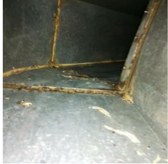
西厨房管道清洗后 3
