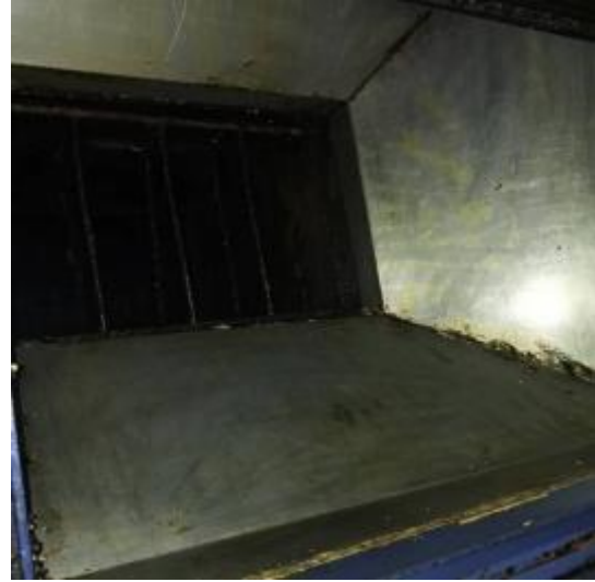
员工厨房管道清洗后 3
