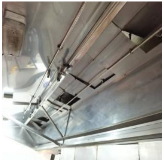
西厨房烟罩清洗后
