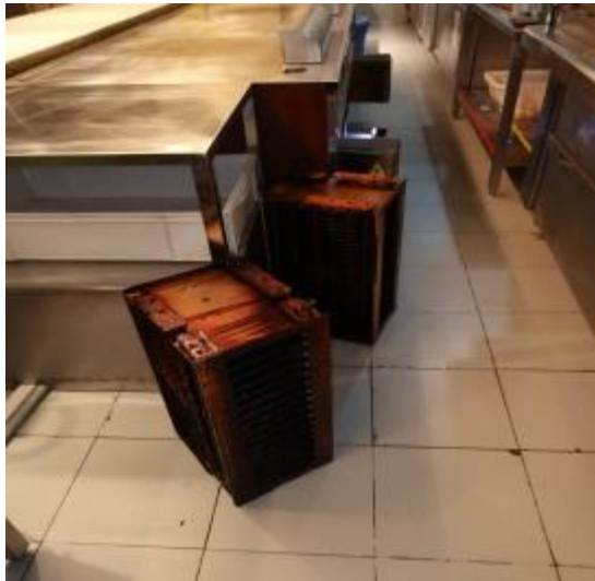
西厨房净化器清洗前
