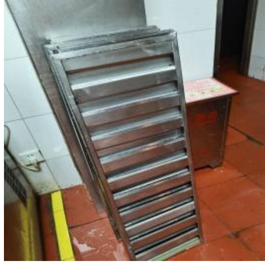
西厨房防火板清洗前
