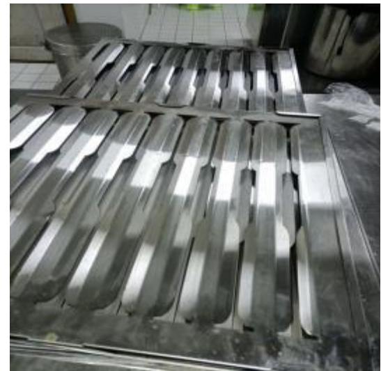
防火板清洗后
