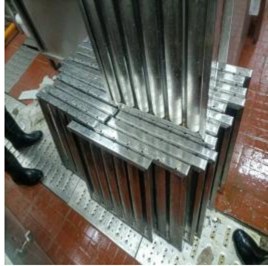
防火板清洗后
