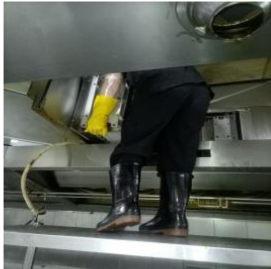
净化器施工中
