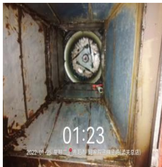
管道风机清洗后
