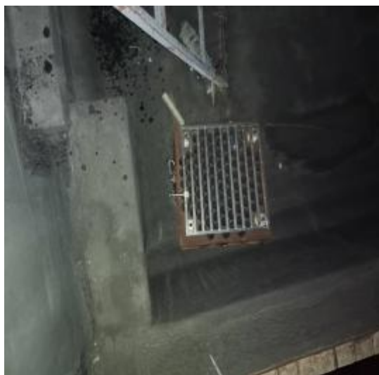
净化器施工中
