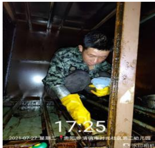
净化器施工中
