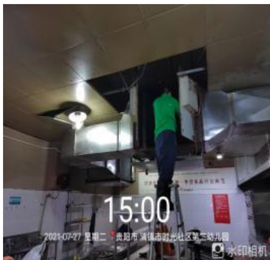
净化器机箱施工中
