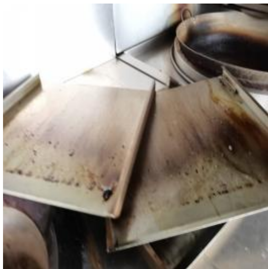
防火板清洗前
