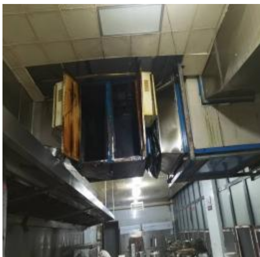
净化器施工中
