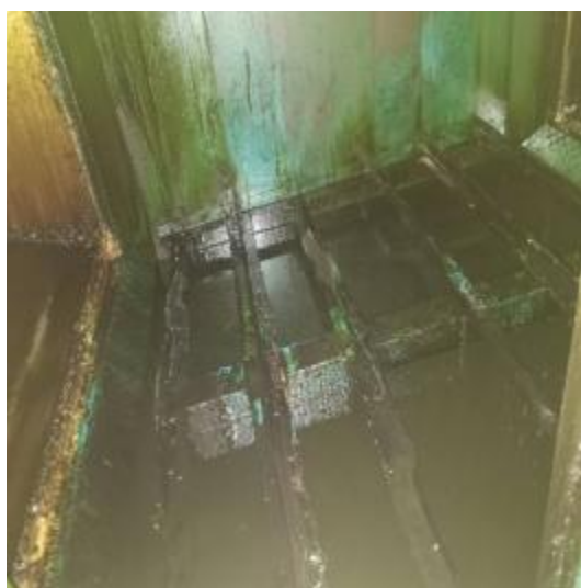
净化器机箱清洗前
