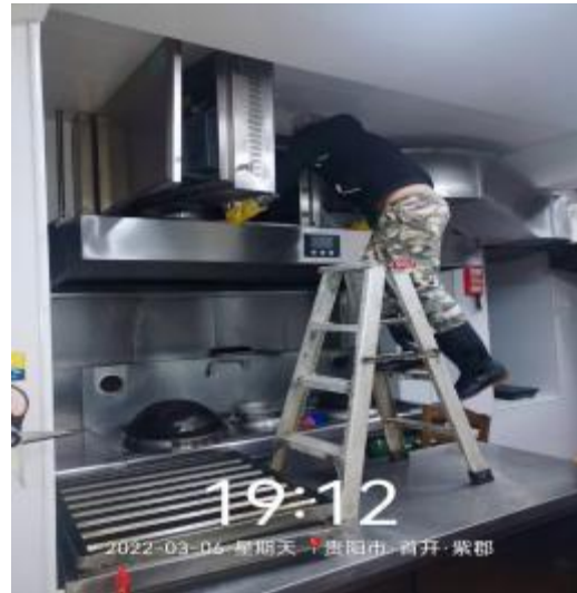
净化器机箱清洗中
