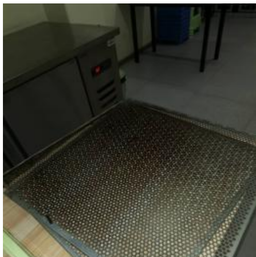
净化器过滤网清洗前
