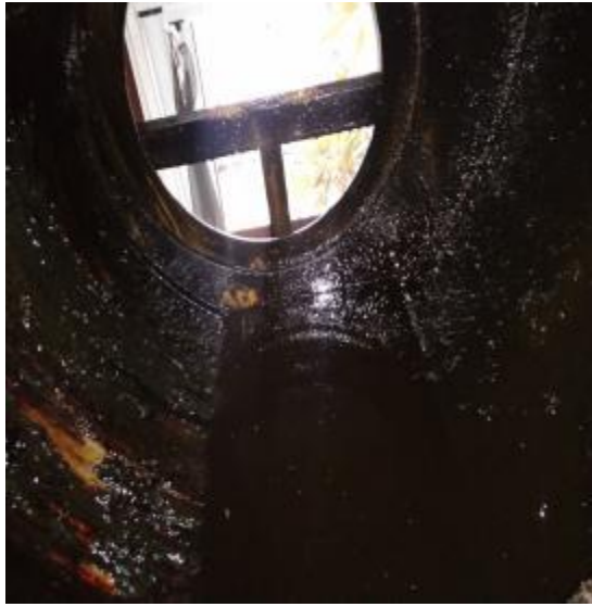
风机内部清洗前
