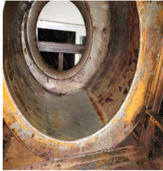
风机内部清洗后
