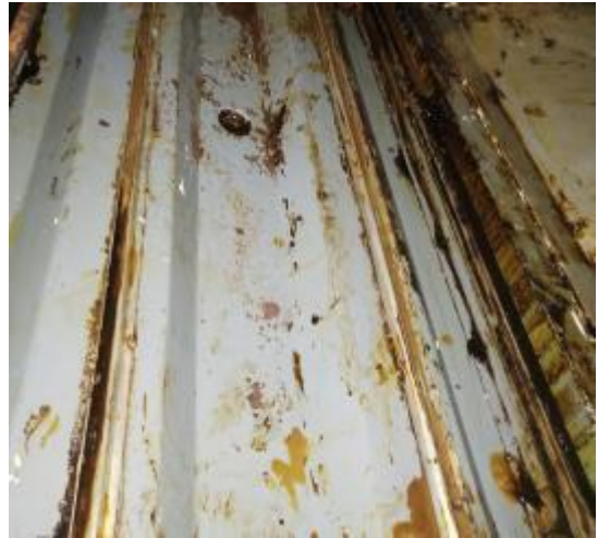
净化器内部清洗后
