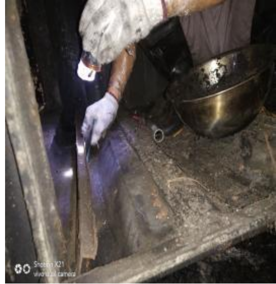
净化器机箱施工 2
