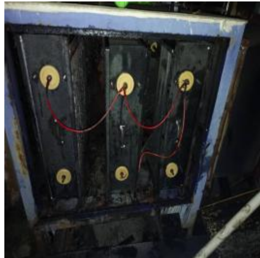
净化器施工中
