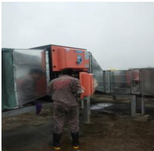
风机及净化器施工
