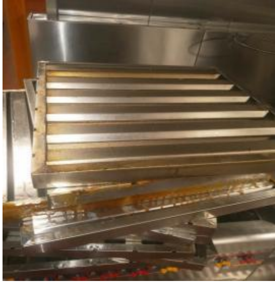
防火板清洗前
