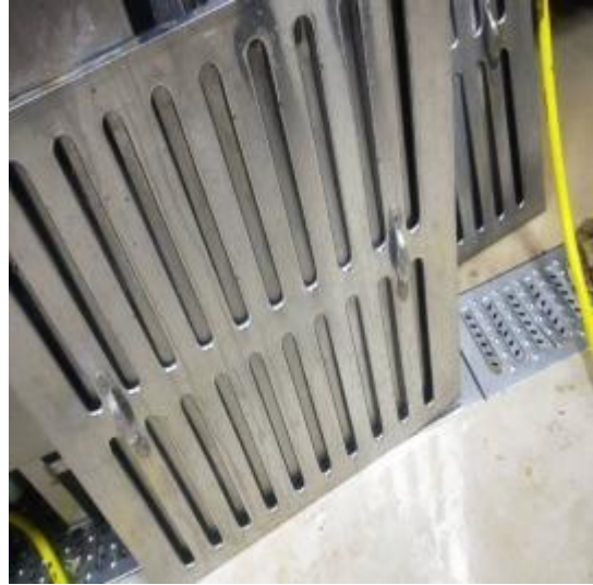
防火板清洗后
