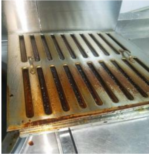
防火板清洗前
