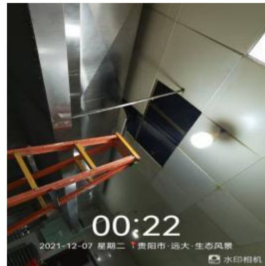
净化器施工中
