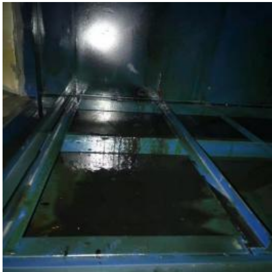
净化器机箱清洗后
