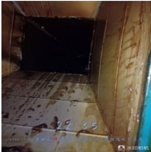
净化器管道清洗前
