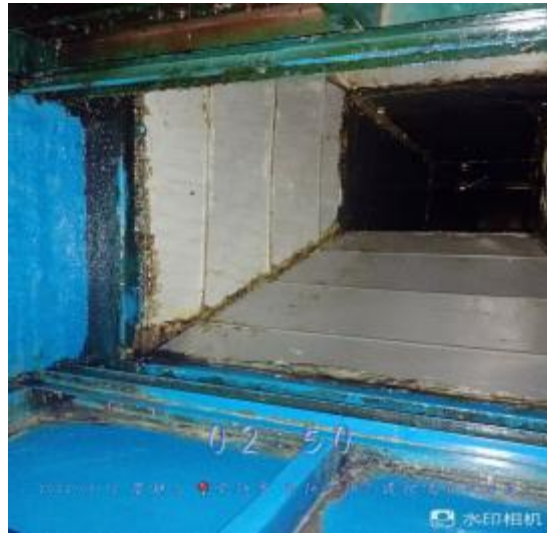
净化器管道清洗后
