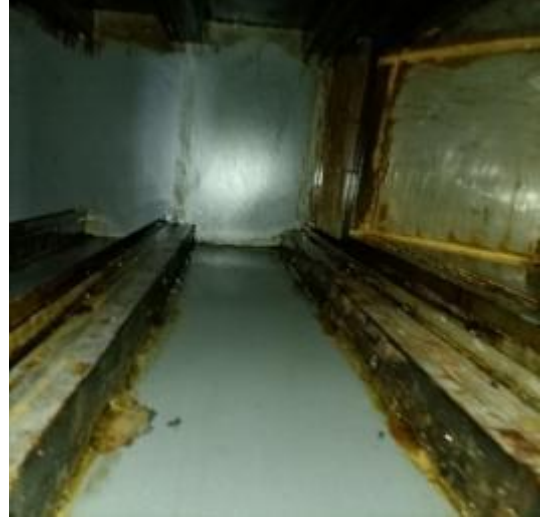
净化器机箱清洗后
