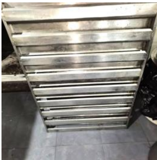
防火板清洗后
