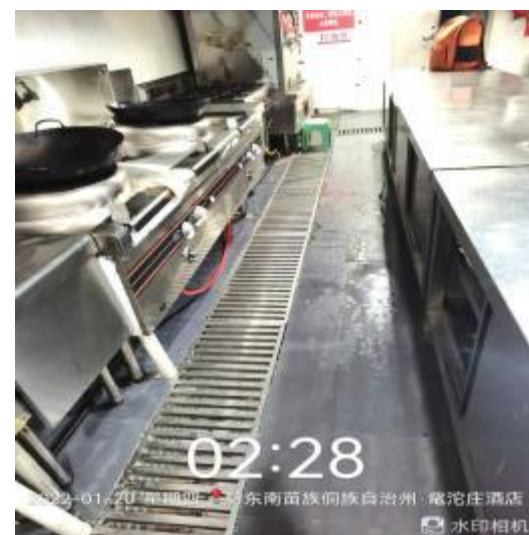
厨房卫生打扫后
