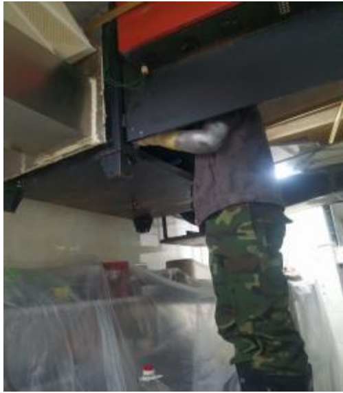
净化器施工中
