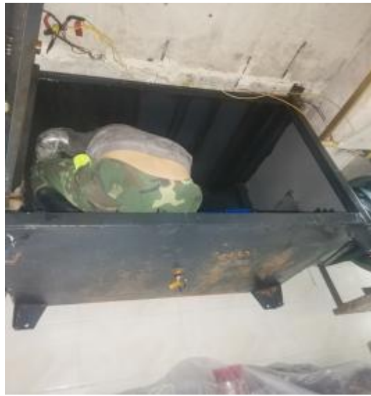
净化器施工中
