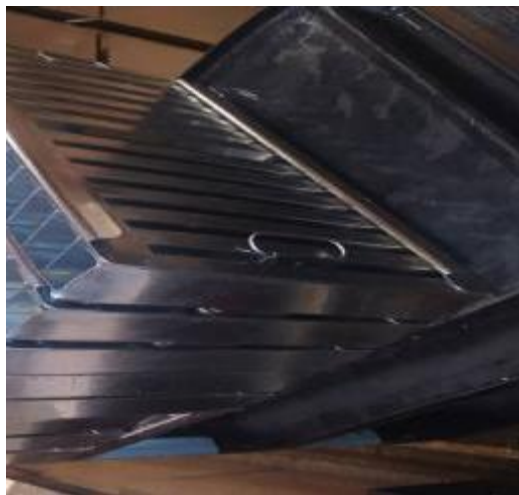
防火板清洗后
