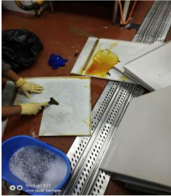
天花板清洗中
