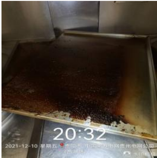
防火板清洗前
