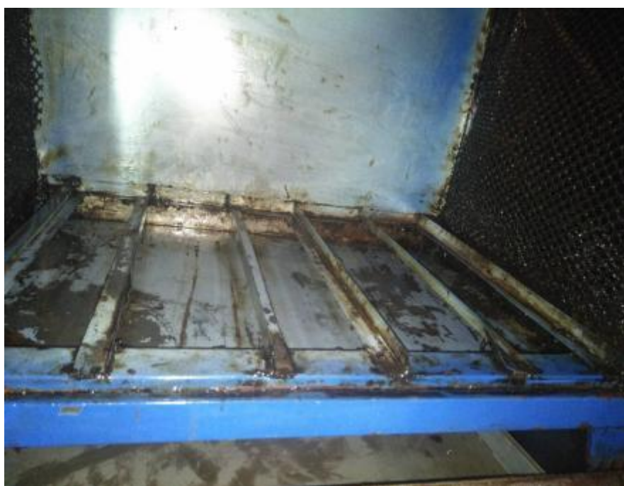
净化器内部清洗后
