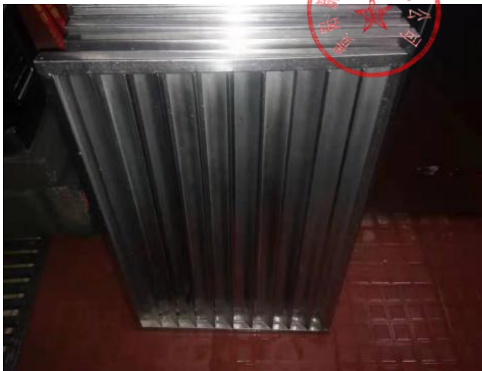
防火板清洗后
