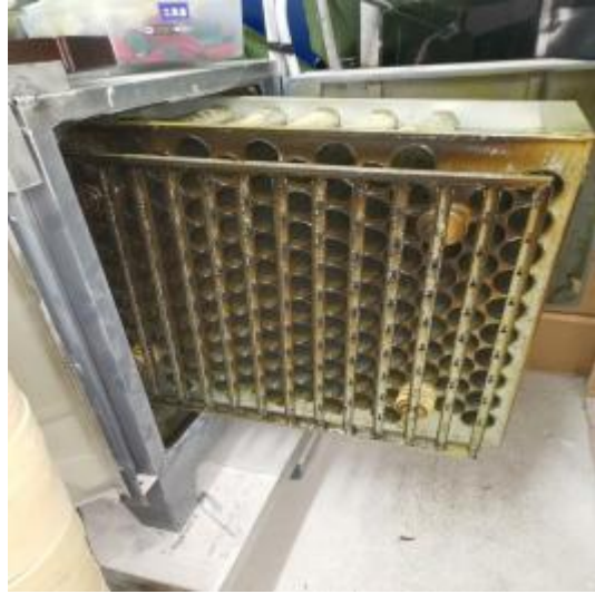
净化器施工中
