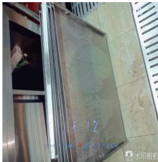
防火板清洗后
