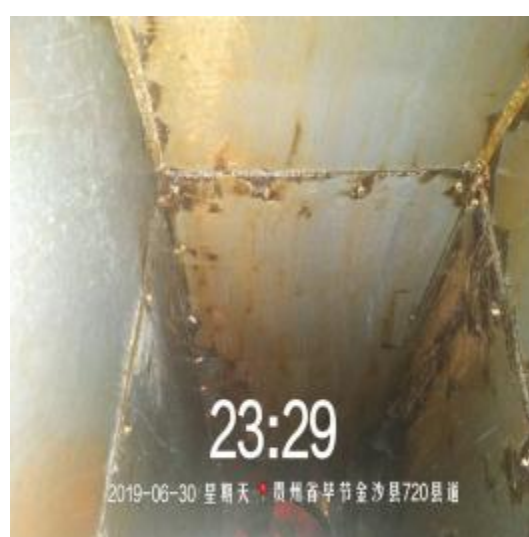
公鸡煲主管道清洗后
