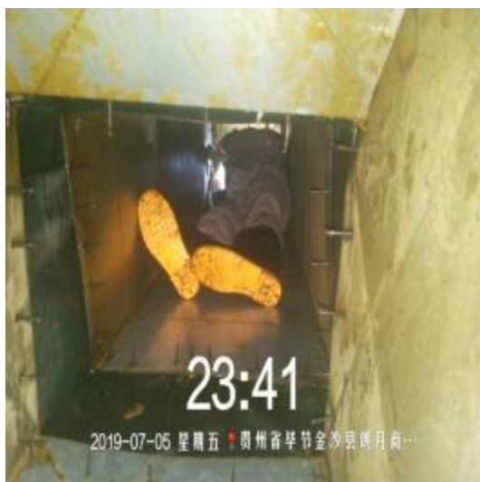
千禧主管道施工 1
