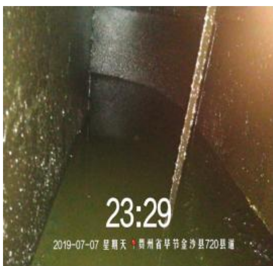
彭厨主管道清洗前 2
