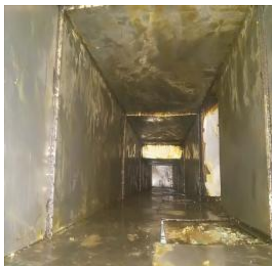
明京大酒楼管道清洗后
