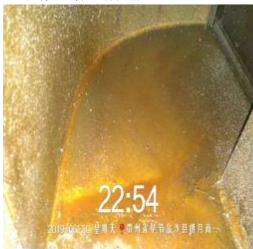
公鸡煲主管道清洗前
