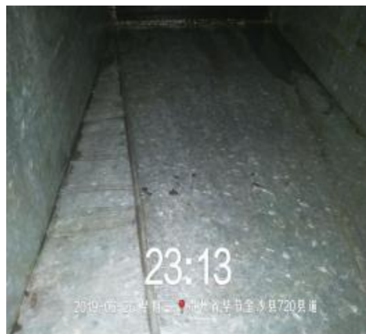
大虎主管道清洗后
