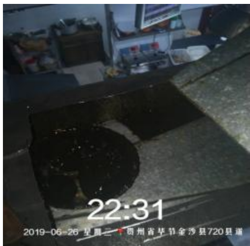
大虎管道施工
