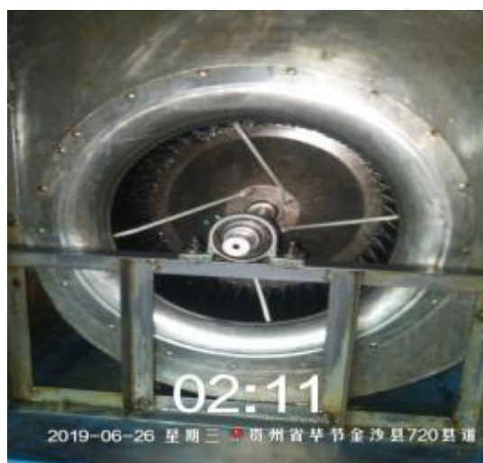
明京大酒楼风机清洗后
