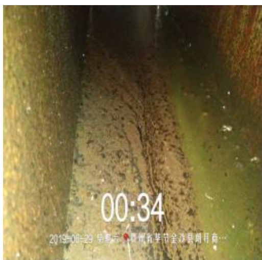
得月楼主管道清洗前
