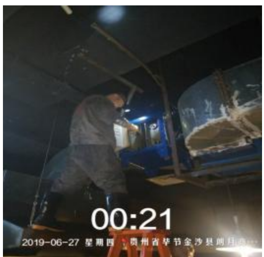
凯里酸汤鱼净化器施工
