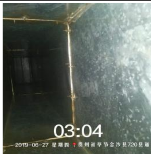
凯里酸汤鱼主管道清洗后
