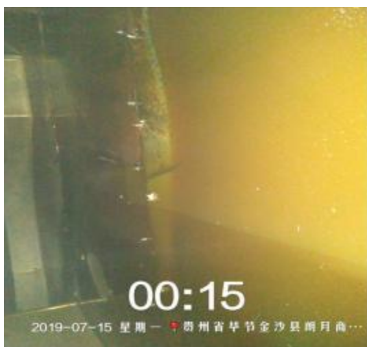
主管道清洗前 3
