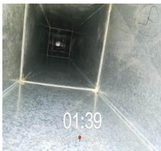
食滋味主管道清洗后 5
