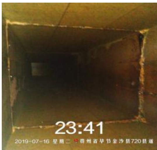
主管道清洗前 1
