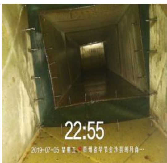
千禧主管道清洗前 1
