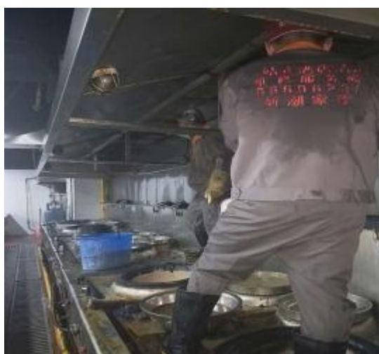
明京大酒楼烟罩施工 1
