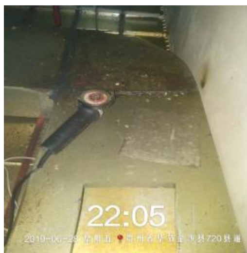
江湖管道施工
