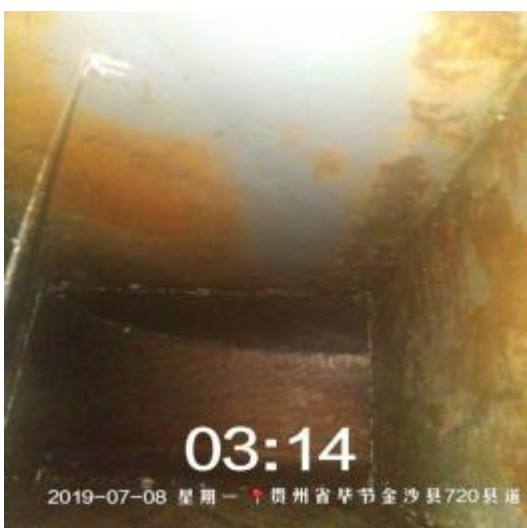
彭厨主管道清洗后 2
