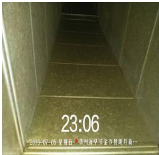
千禧主管道清洗前 2
