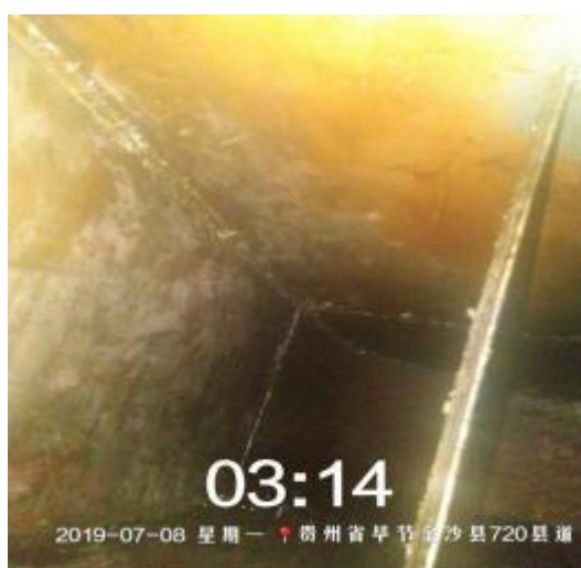
彭厨主管道清洗后 1
