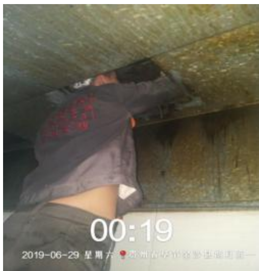
得月楼管道施工
