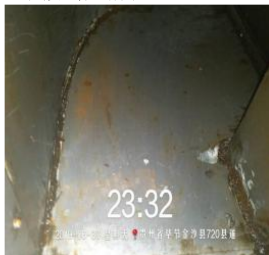
公鸡煲主管道清洗后
