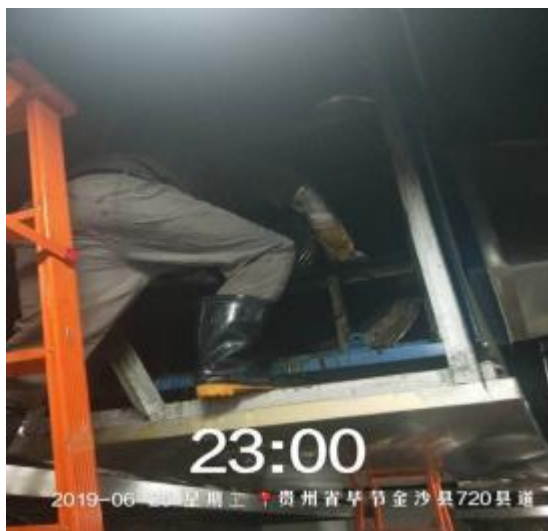
明京大酒楼风机施工
