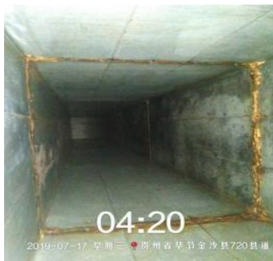
主管道清洗后 1
