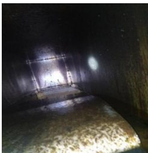
得月楼管道清洗前
