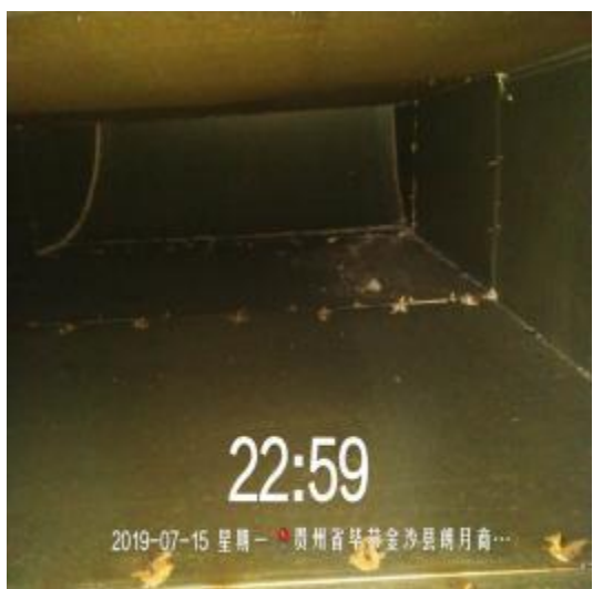
主管道清洗前 4
