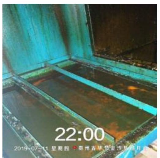
蛙先生净化器内部清洗前
