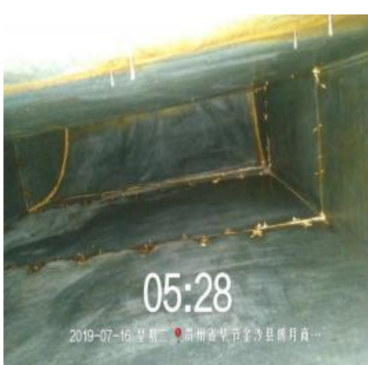
主管道清洗后 4
