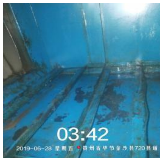
小高山火锅净化器内部清洗后
