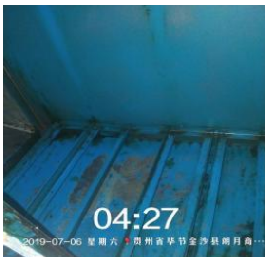
千嘻净化器内部清洗后
