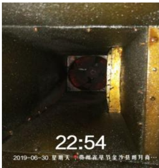
公鸡煲主管道清洗前
