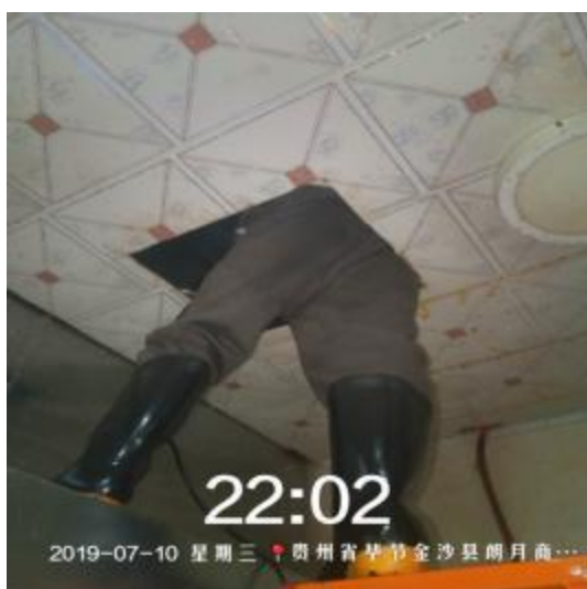
食滋味管道施工
