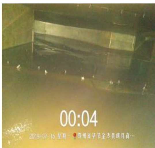
主管道清洗前 2
