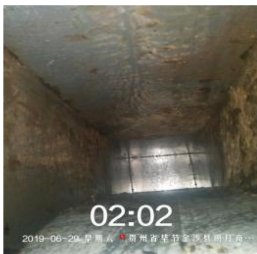
得月楼管道清洗后
