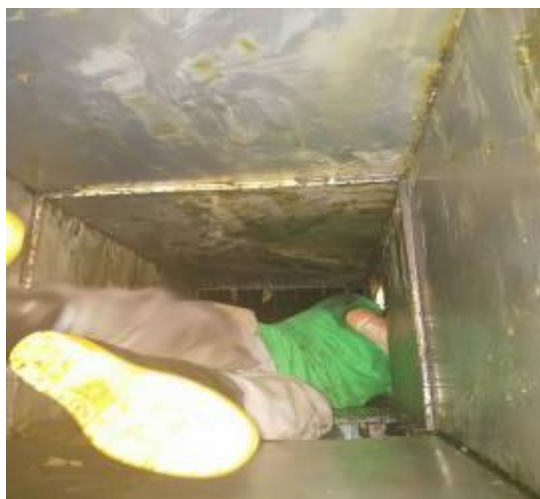
明京大酒楼管道施工 1
