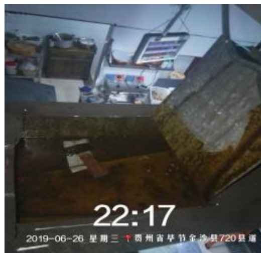
大虎管道施工
