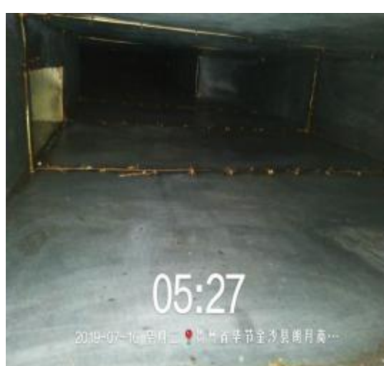
主管道清洗后 2
