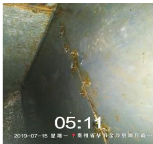
主管道清洗后 3
