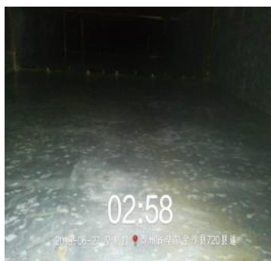
凯里酸汤鱼管道清洗后
