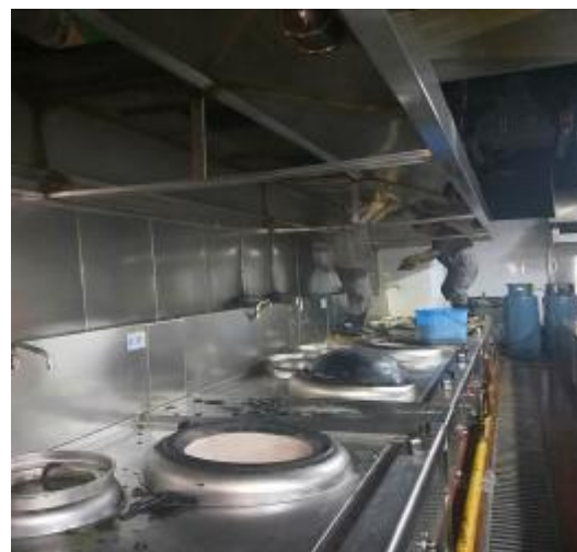
明京大酒楼烟罩施工 2
