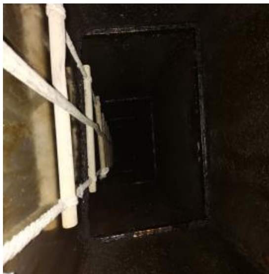
垂直管道清洗前 3
