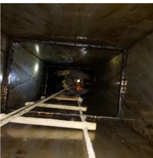
垂直管道施工 4
