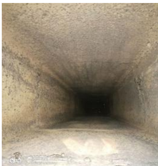
垂直管道清洗前 2
