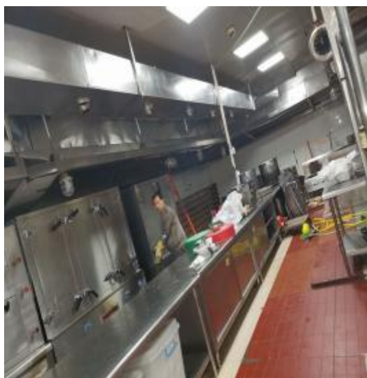
新风管清洗后
