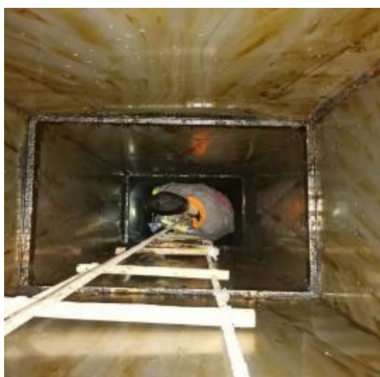
垂直管道施工 1
