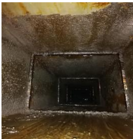
垂直管道清洗前 1
