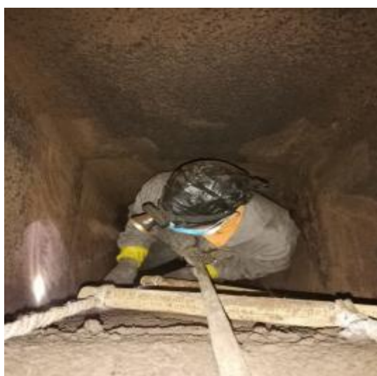
垂直管道施工 2
