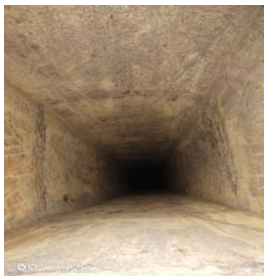
垂直管道清洗后 2
