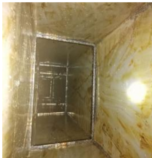
垂直管道清洗后 1
