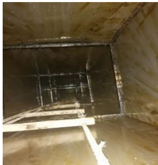
垂直管道清洗后 3
