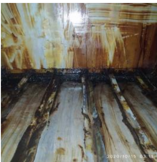
净化器机箱清洗后
